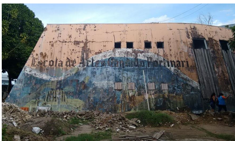
Figura 17 – A degradação do CEPAV Cândido Portinari.
