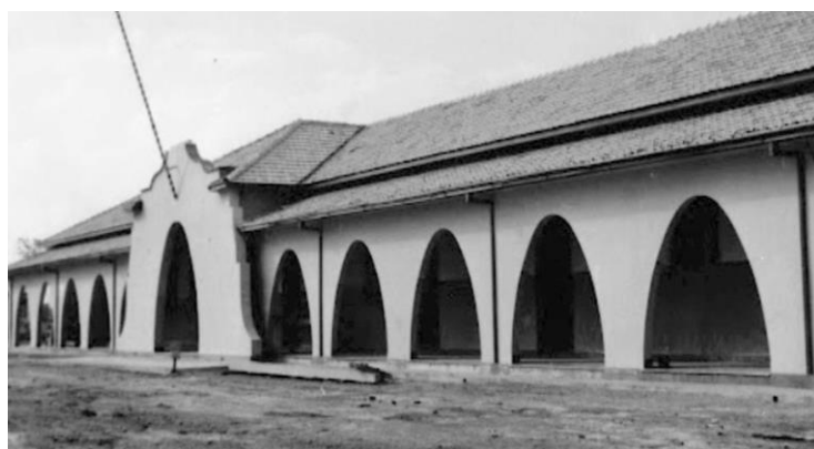
Figura 06 – Prédio do antigo Ginásio de Macapá – GM.
