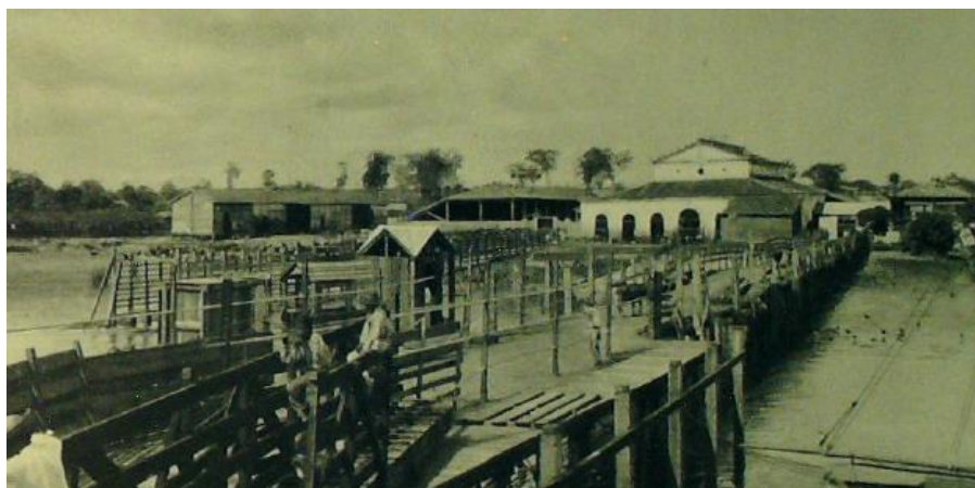
Figura 23– Estrutura externa do Matadouro.
