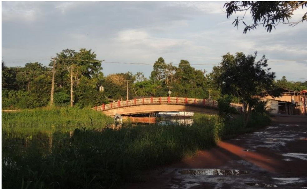
Figura 24 - Ponte da Rodovia do Pacoval, que delimita o fim da área de intervenção.
