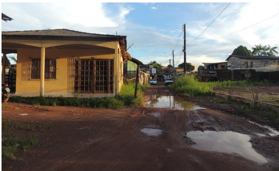
Figura 33 - Ausência de pavimentação nos arredores do Canal.
