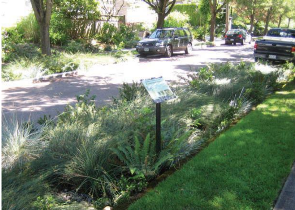
Figura 7 - Jardim de chuva disposto em uma via na cidade de Portland, EUA.
