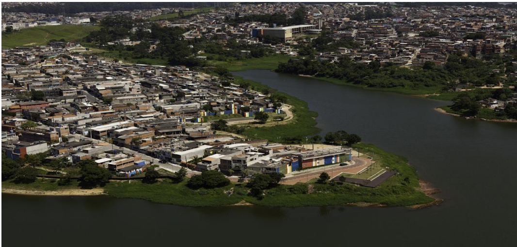
Figura 50 - Imagem aérea da intervenção realizada.
