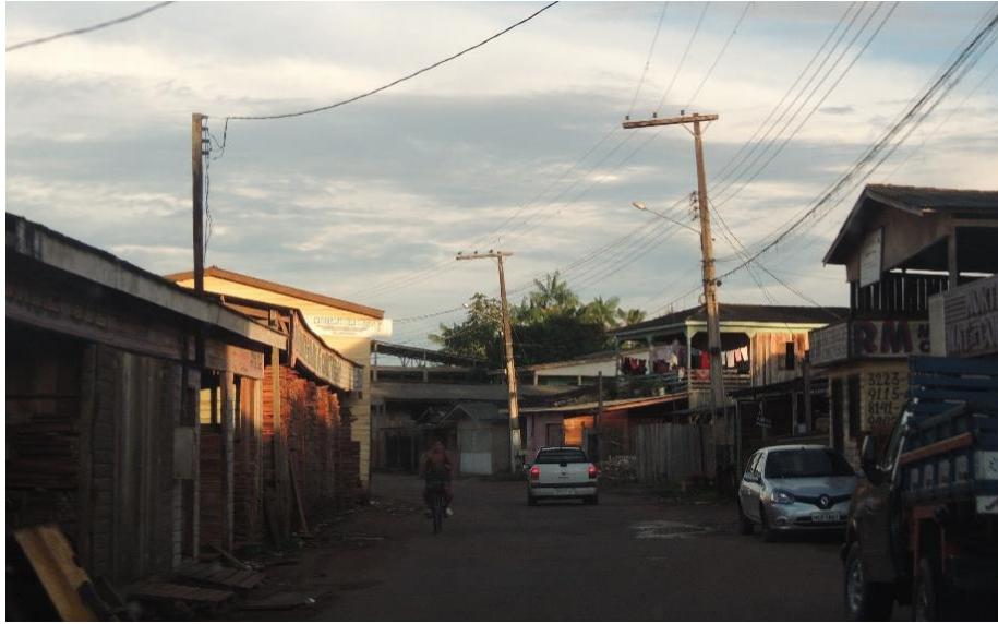
Figura 34 - Trecho pavimentado da Avenida Canal do Jandiá.
