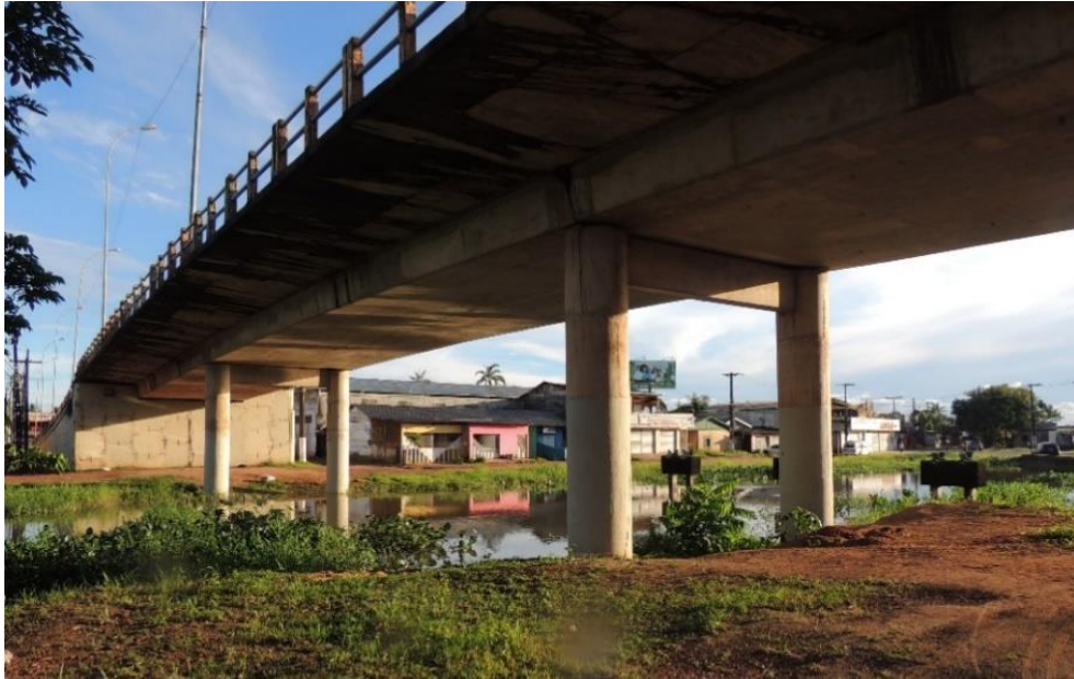
Figura 23 - Ponte Sérgio Arruda, que delimita o início da área de intervenção.
