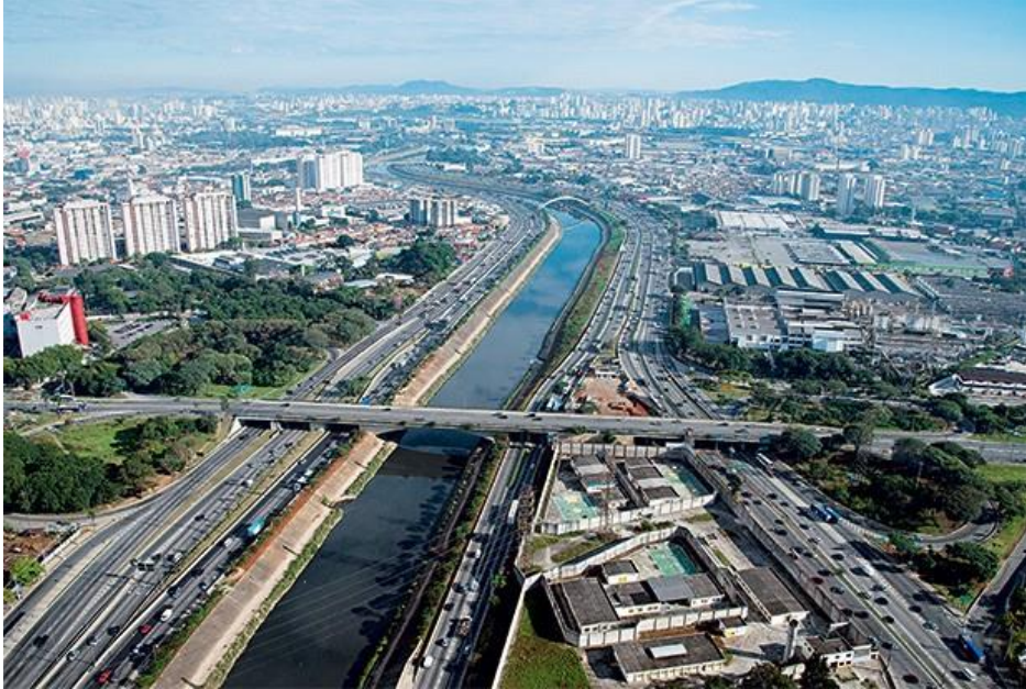
Figura 11 - Infraestrutura viária às margens do rio Tietê, em São Paulo.
