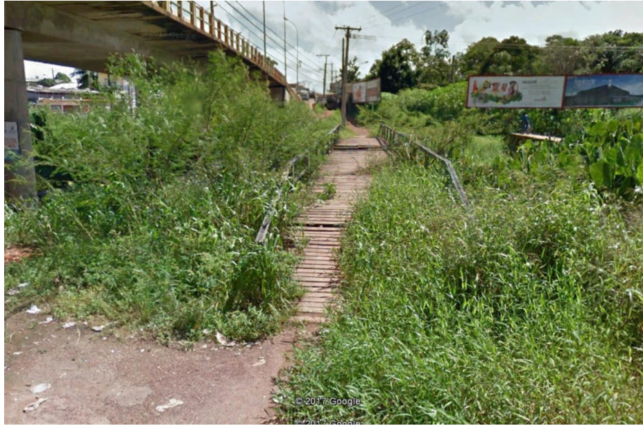
Figura 43 - Ponte peatonal cruzando o Canal.
