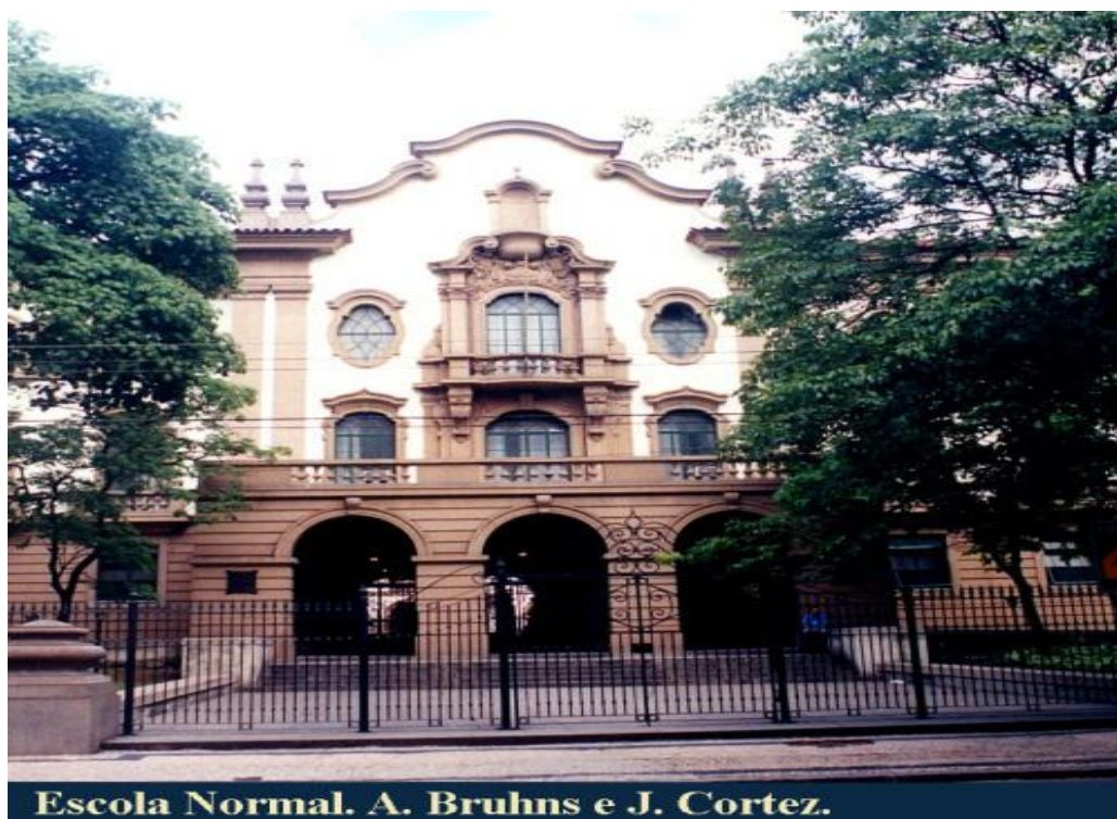
Figura 01: Arquitetura escolar Neocolonial Fonte: https://coisasdaarquitectura.wordpress.com/
