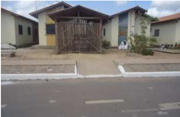
Figura 20.3 e 20.4- Quebra do passeio público para construção de rampas e avanço de muro no passeio público
