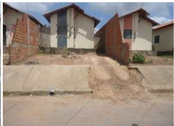
Figura 20.3 e 20.4- Quebra do passeio público para construção de rampas e avanço de muro no passeio público
