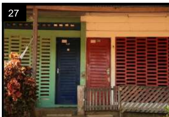
Figura 27 - painéis de elemento vazado
