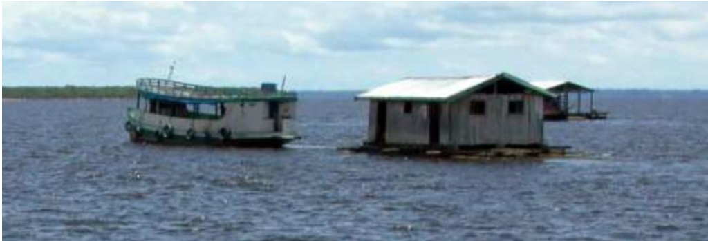
Figura 11 – Casa flutuante, com cobertura em telha metálica.
