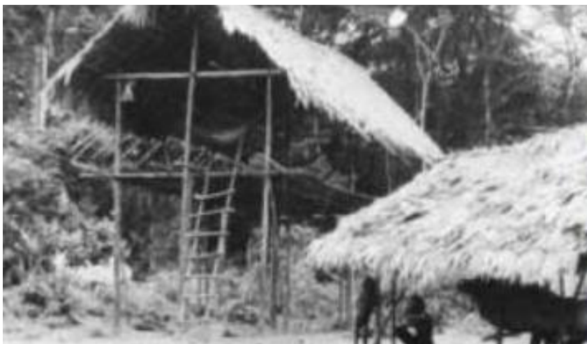
Figura 9 - Casa palafítica com cobertura simplificada – tapiri Aldeia Nipuku.
