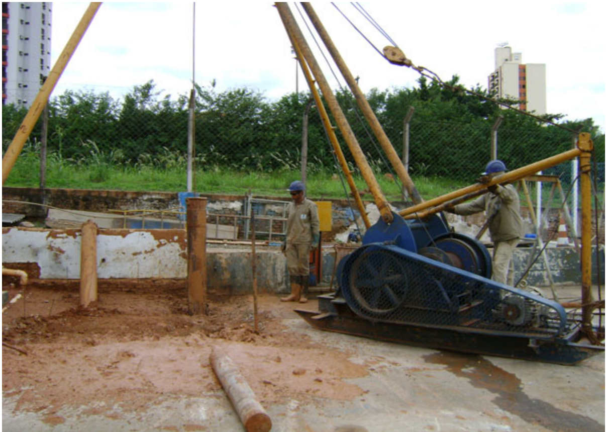
Figura 6 – Cravação de estacas de madeiras com bate-estaca
