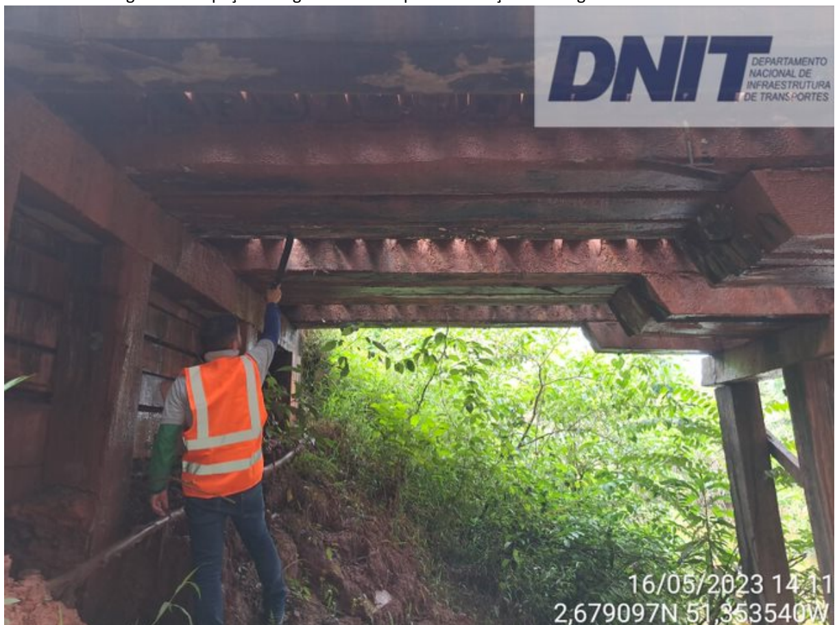
Figura 9 – Inspeção do agente do DNIT para verificação da integridade da madeira
