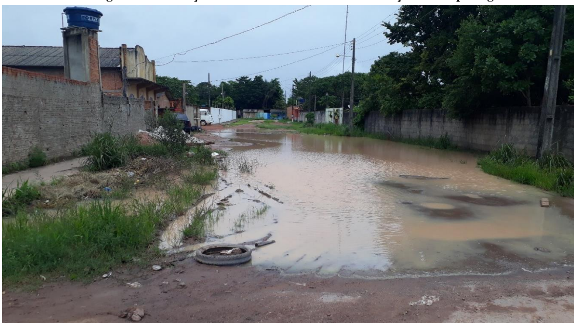
Imagem 14 – Condições da via El Shaddai antes do serviço de terraplanagem
