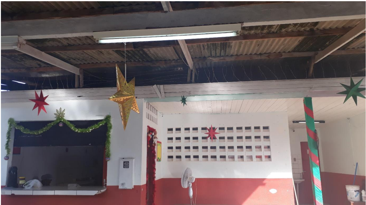
Imagem 20 – Estrutura improvisada utilizada como meio de segurança na escola Sandra Lobato Ferreira
