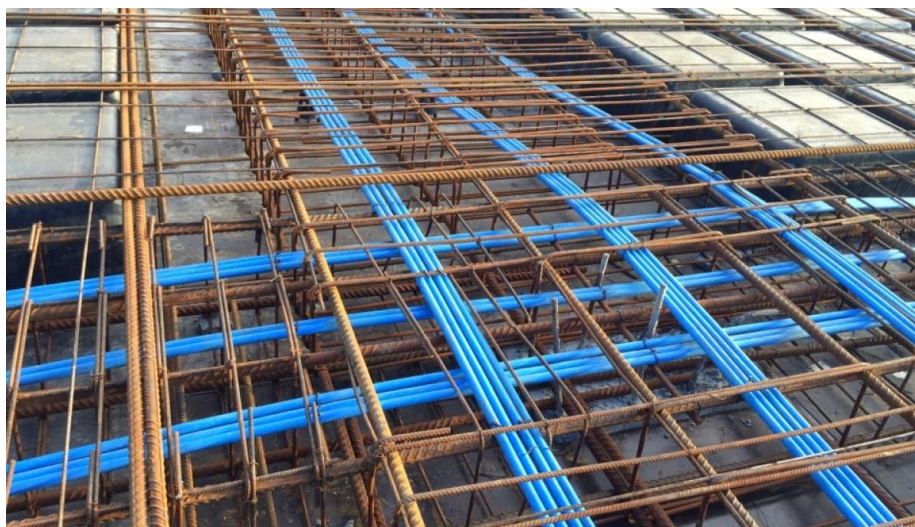
Figura 64 – Laje protendida.
