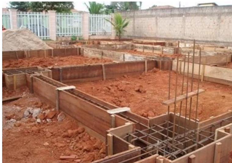
Figura 61 – Sapatas Isoladas e Viga Baldrame.
