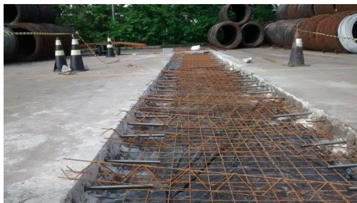
Figura 72 – Piso em concreto com armação em aço.
