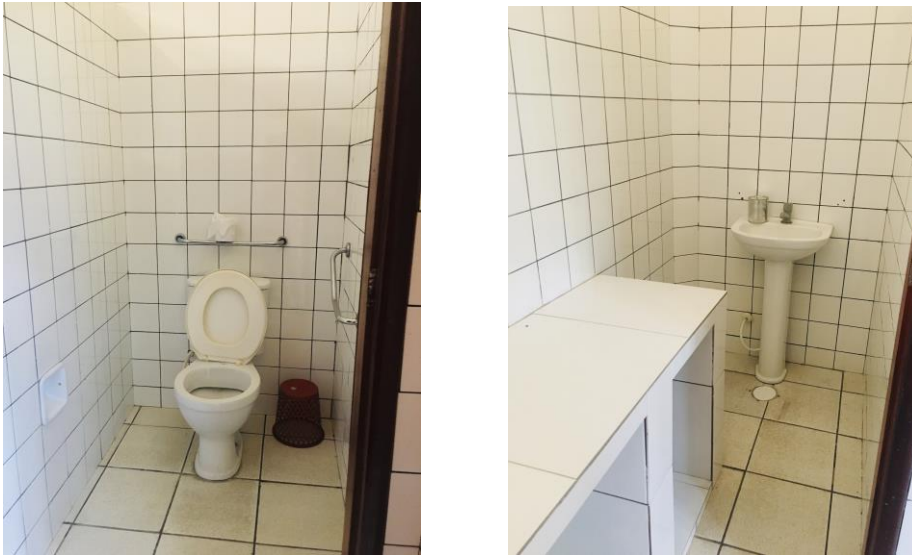
Figura 2 – Escola 2: banheiro adaptado
