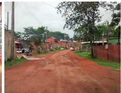
Figura 51: Final da via principal "Av. Jardim América"
