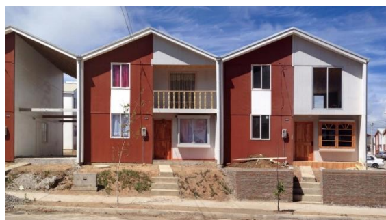
Figura 12: Projeto Villa Verde após ocupação – Chile
