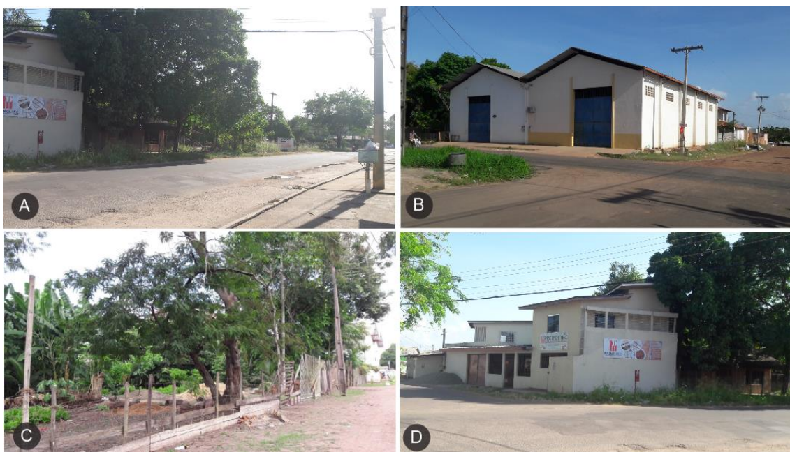
Figura 52 – A e C: Fachada norte; B: Esquina da fachada norte com a fachada oeste; D: Esquina da fachada norte com a fachada leste
