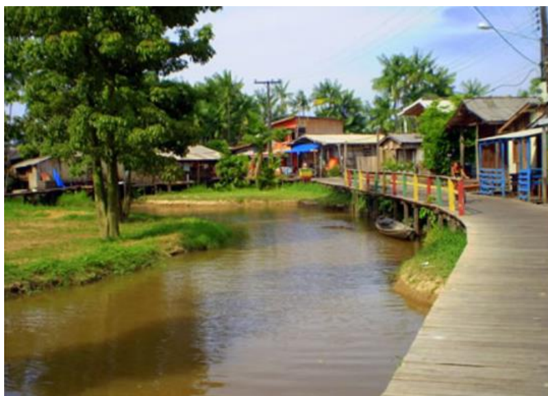
Figura 15 - Passarelas de madeira construídas sobre rios e lagos, Afuá/PA
