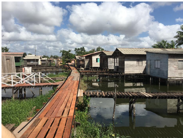
Figura 27 - Ponte de madeira localizada na 15ª avenida do Congós, reformada pela comunidade em 2016
