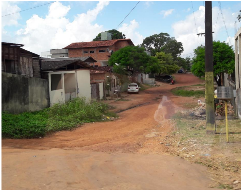
Figura 45 - Cenário de transição entre a área consolidada e área de ressaca
