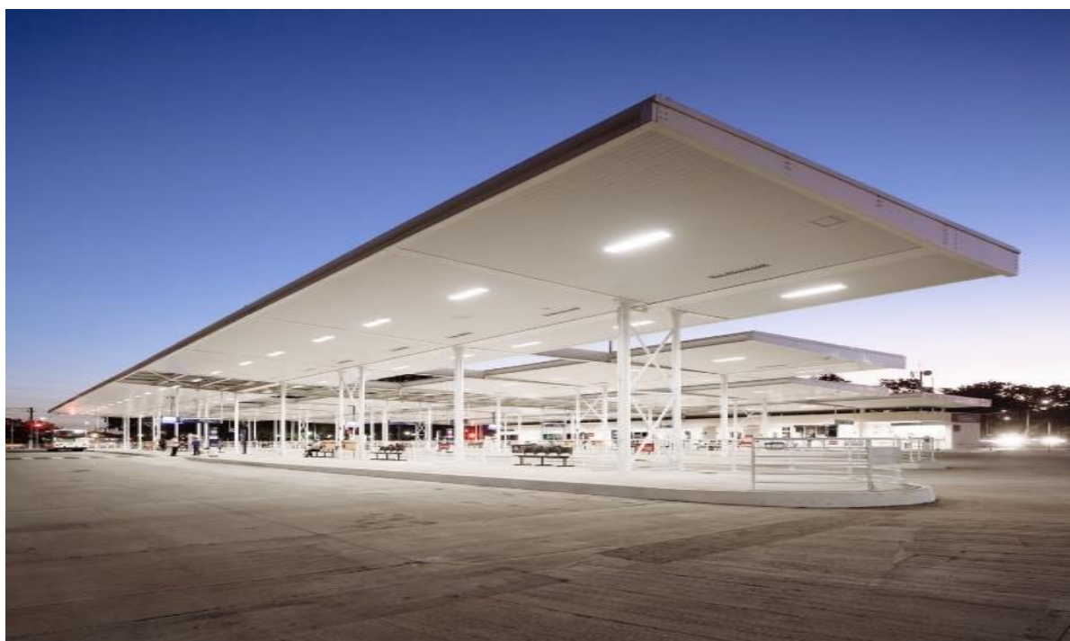
Figura 17: Cobertura e estrutura do terminal
