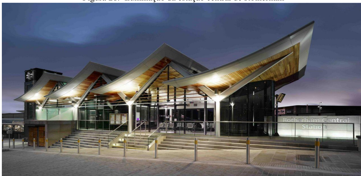
Figura 28: Iluminação da estação central de Rotherham
