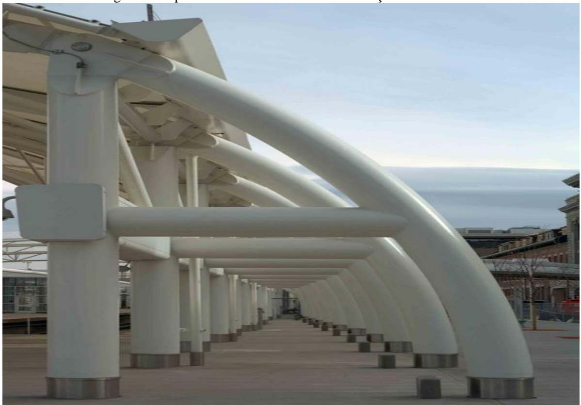
Figura 24: Apoio estrutural da cobertura da Estação Denver Union
