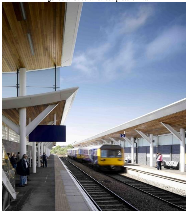
Figura 30: Coberturas das plataformas
