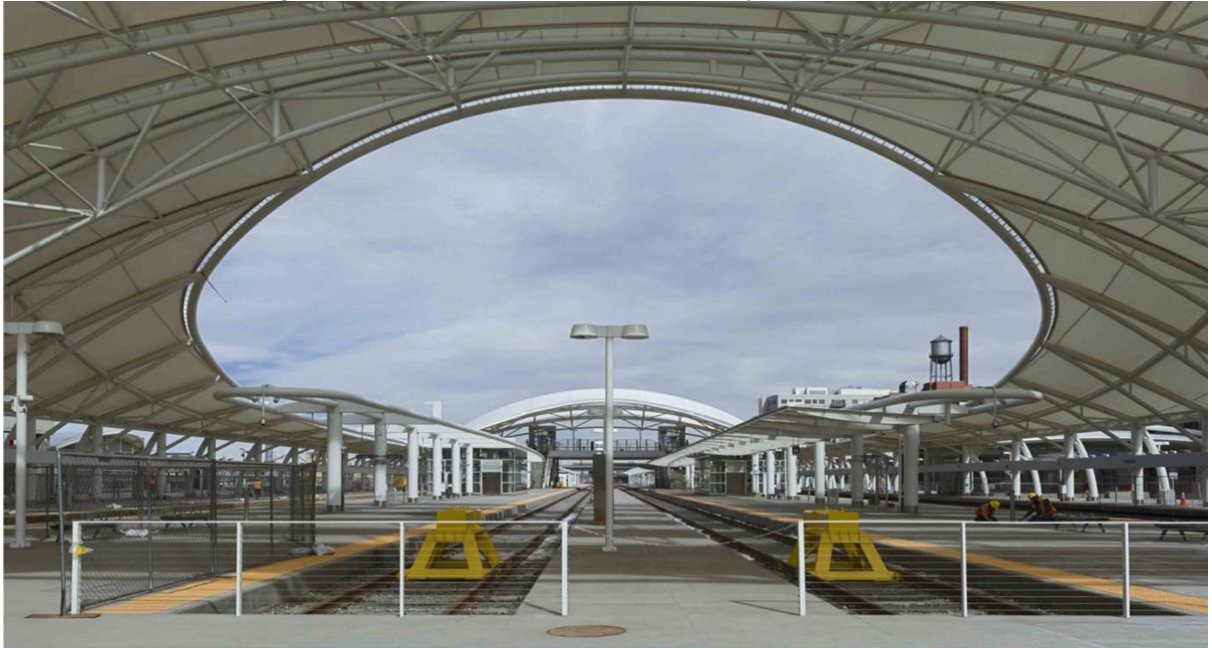
Figura 23: Estrutura da Cobertura da Estação Denver Union
