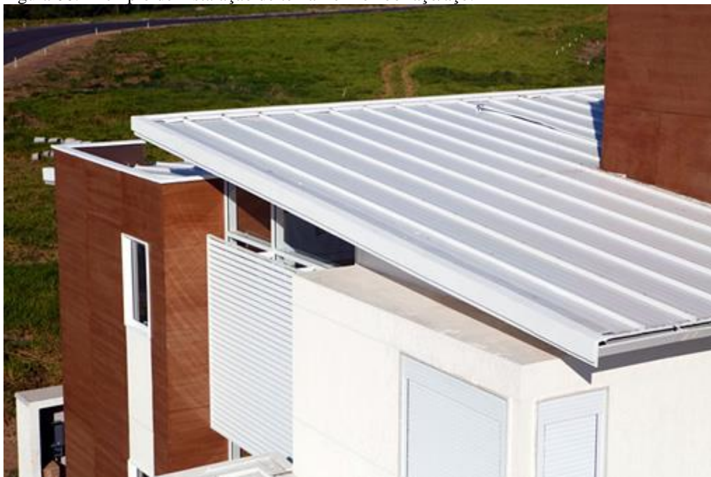
Figura 06: Exemplo de instalação de telha TermoRoof aço/aço.
