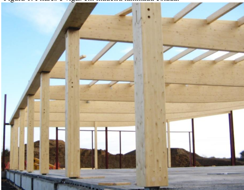
Figura 1: Pilares e vigas em madeira laminada colada.
