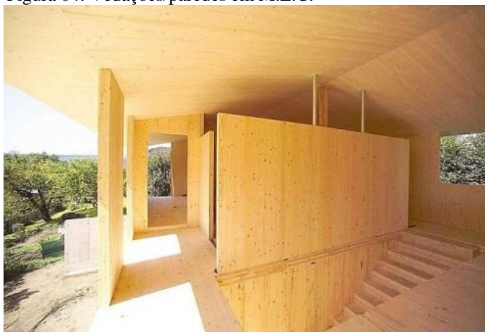
Figura 04: Vedações/paredes em M.L.C.
