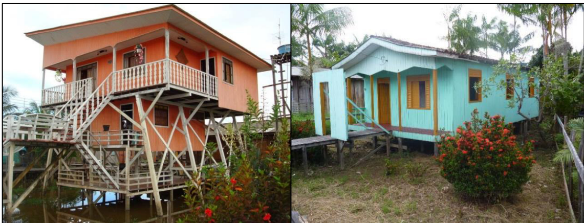
Figura 07 – Habitações encontradas no perímetro da cidade.
