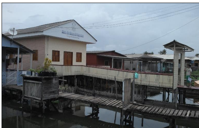
Figura 37 – Igreja Universal instalada na área de ressaca.
