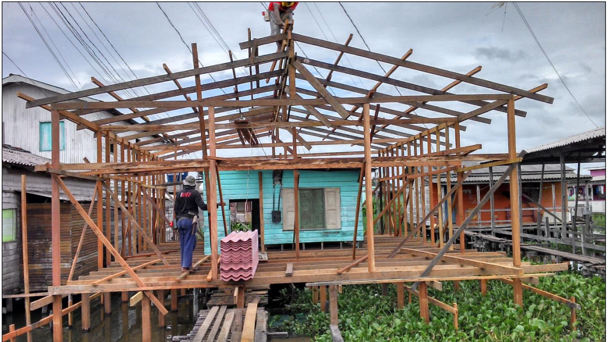
Figura 34 – Habitação sendo construída na área de ressaca.
