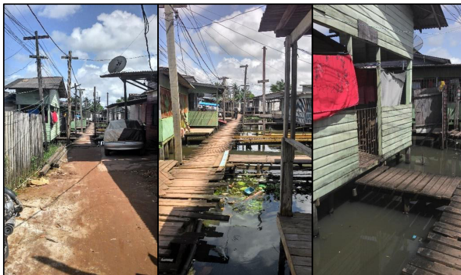
Figura 29 – Passarelas existentes na área.
