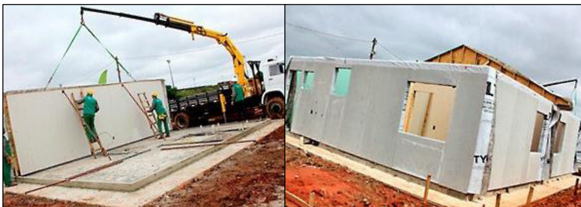
Figura 12 – Processo construtivo das residências utilizando painéis de Wood Frame.
