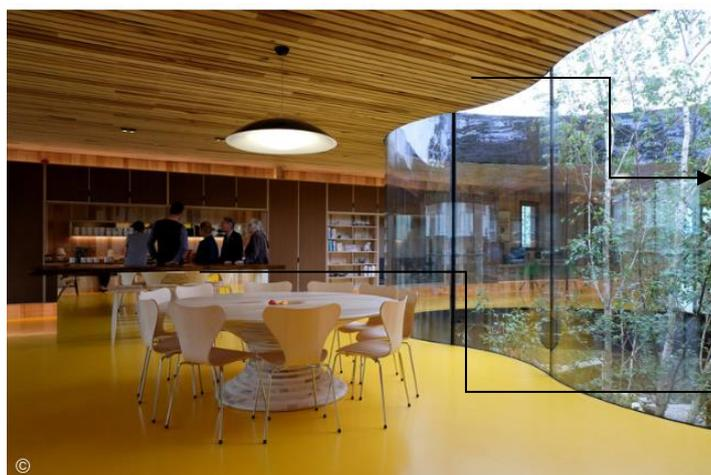
Forro com sobras de madeiras da fabricação dos painéis CLT.
