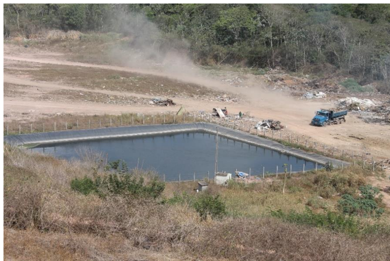
Figura 12 - Lagoa de lixiviado
