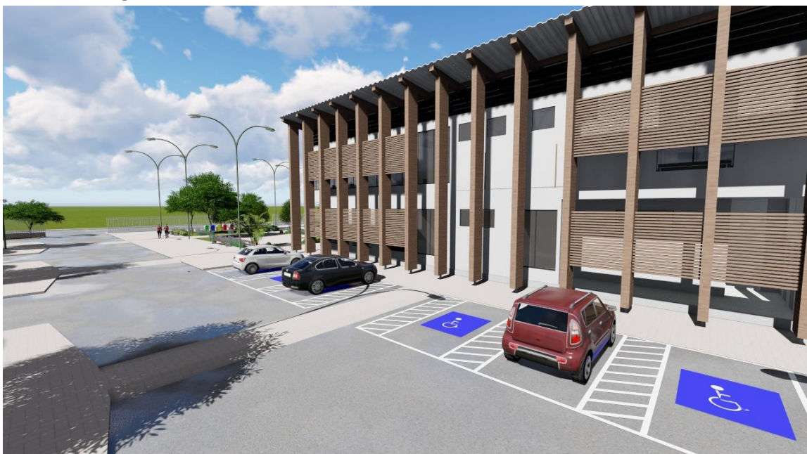
Figura 64 - Fachada Oeste com Brises verticais e venezianas metálicas.
