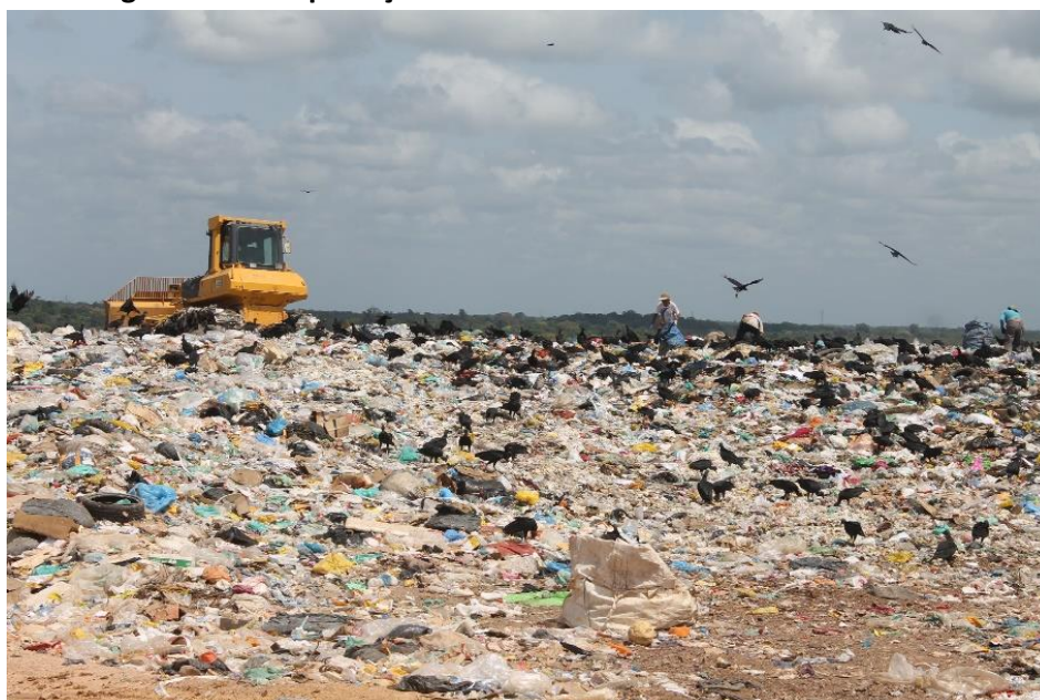
Figura 19 - Compactação dos resíduos na célula sanitária
