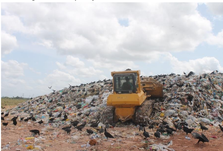
Figura 18 - Compactação dos resíduos na célula sanitária
