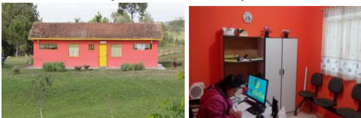
Figura 38 - Bloco administrativo, Tibagi-PR.
