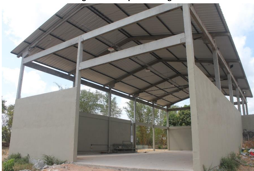
Figura 23 - Galpão de triagem
