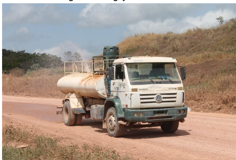
Figura 13 - Irrigação dos acessos
