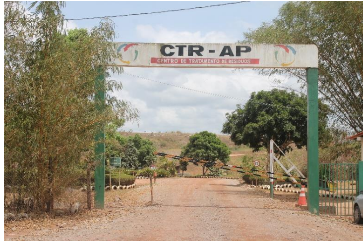
Figura 26 - Entrada principal do Aterro de Macapá
