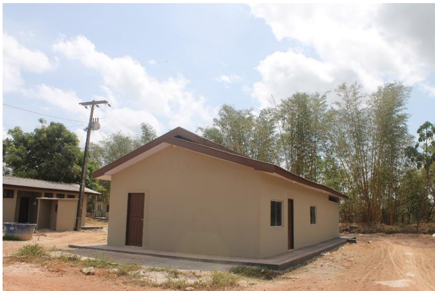
Figura 24 - Bloco Administrativo do galpão de triagem
