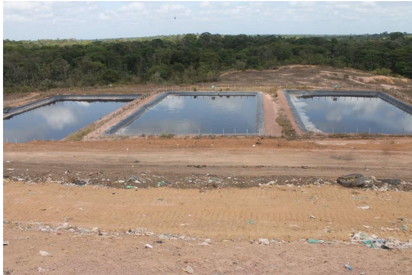
Figura 16 - Lagoas de lixiviados das células sanitárias.
