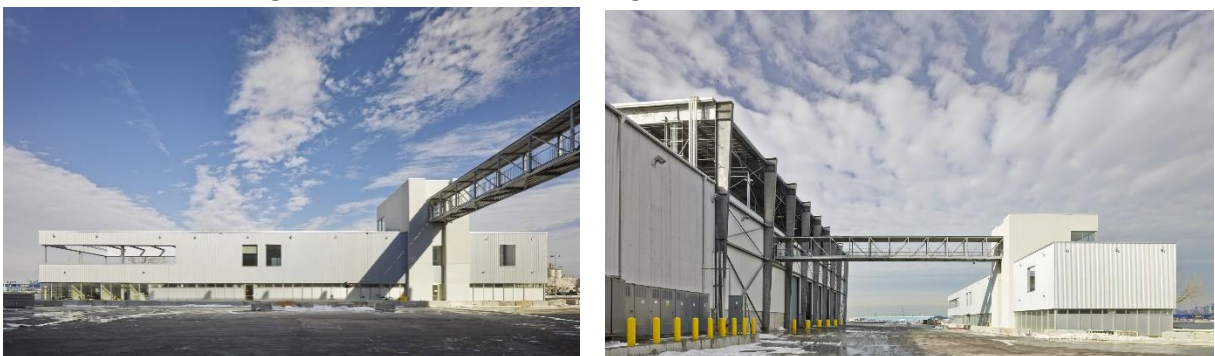
Figura 33 - Passarela met lica ligando os blocos de edif cios
