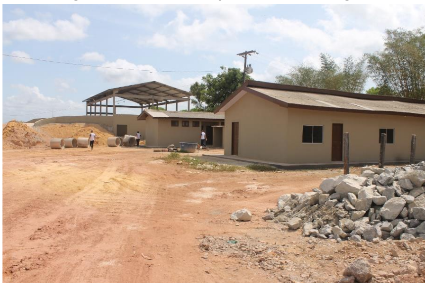
Figura 22 - área de instalação do Centro de triagem
