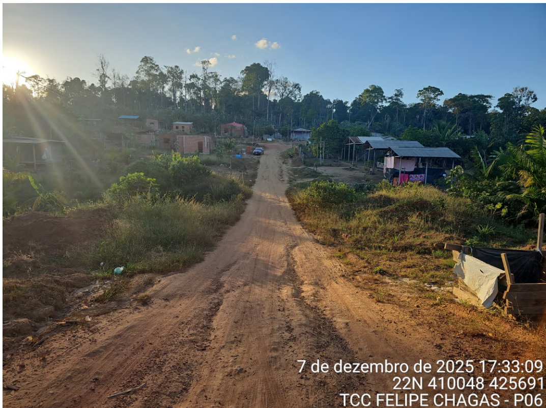
Figura 72: Ponto de alagamento P06.
