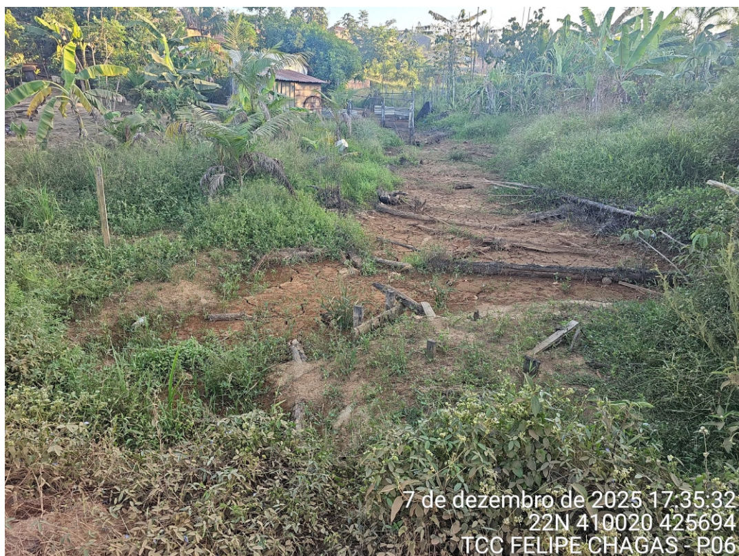
Figura 74: Ponto de alagamento P06 - Lateral jusante durante estiagem.
