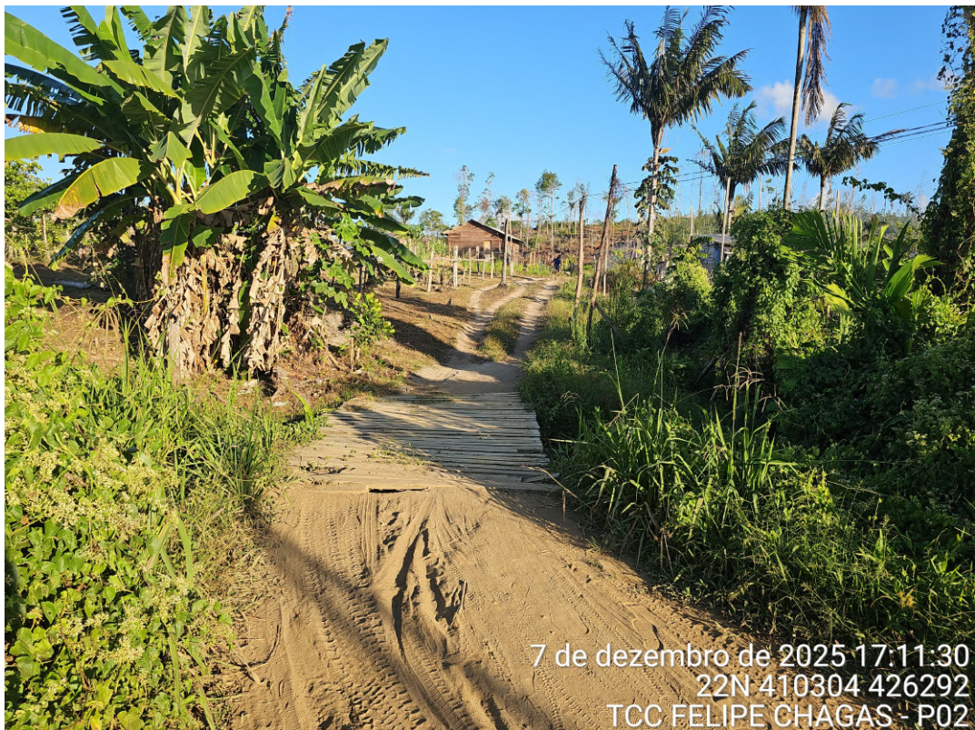
Figura 68: Ponto de alagamento P02.
