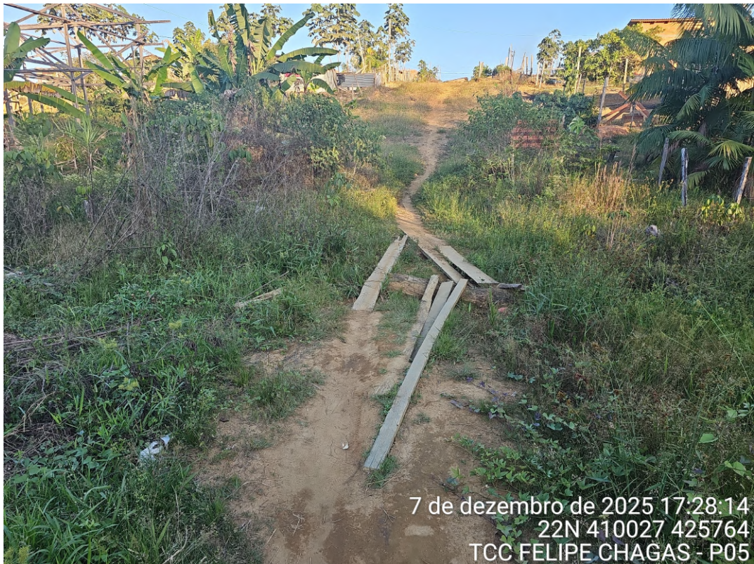
Figura 71: Ponto de alagamento P05.
