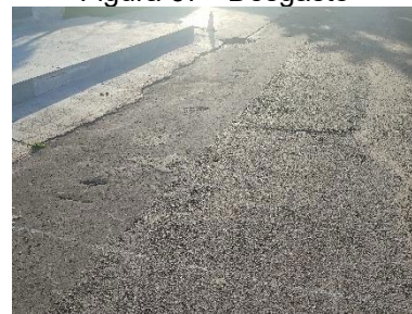
Figura 37 - Desgaste
