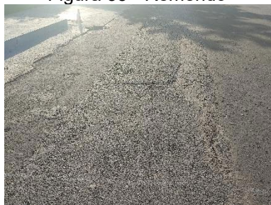
Figura 35 - Remendo
