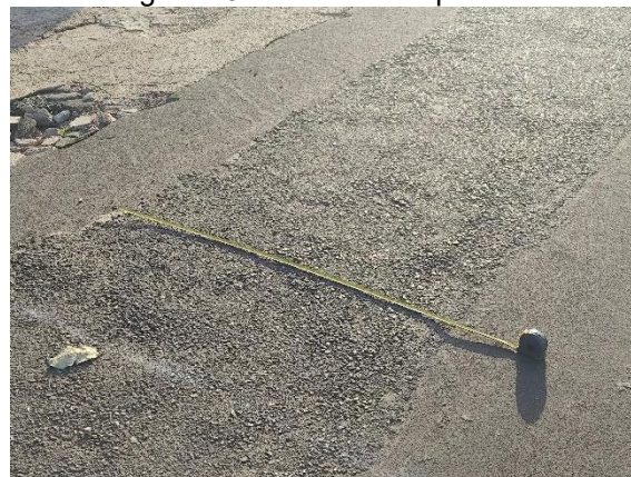
Figura 43 - Remendo superficial
