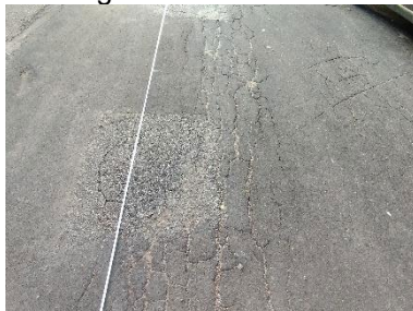
Figura 55 - Remendo
