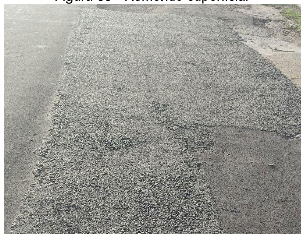
Figura 33 - Remendo superficial
