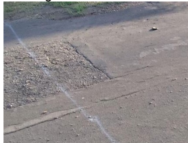
Figura 47 - Remendo
