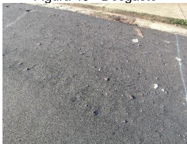
Figura 40 - Desgaste
