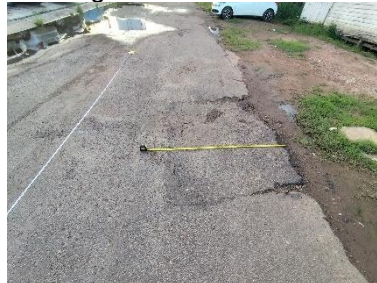
Figura 60 - Remendo
