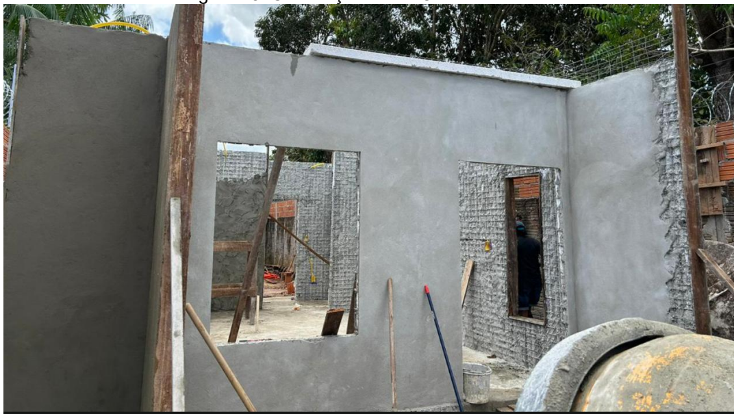
Figura 18: Construção da AROM - Fazendinha
