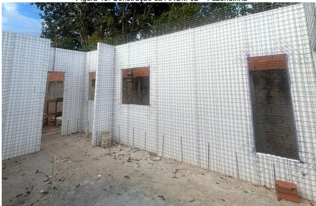
Figura 19: Construção da AROM 02 – Fazendinha
