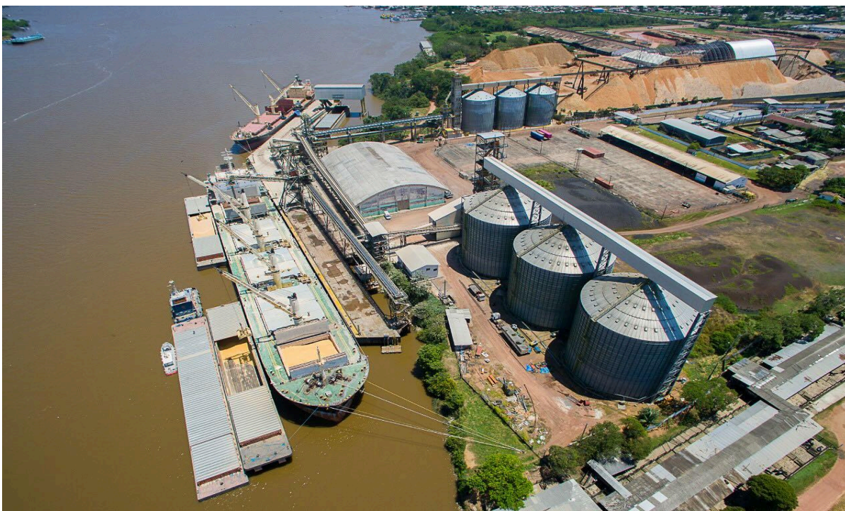
FIGURA 8. Infraestrutura do Porto de Santana.
