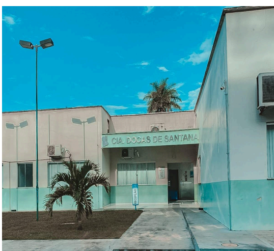
FIGURA 6. Prédio Administrativo da CDSA.
