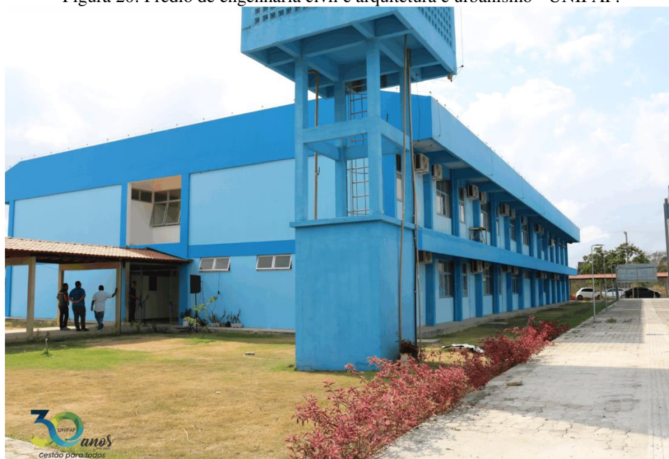
Figura 20: Prédio de engenharia civil e arquitetura e urbanismo - UNIFAP.
