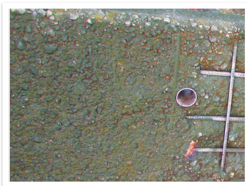
Figura 38 - Detalhe do barbacã na placa pré-moldada
