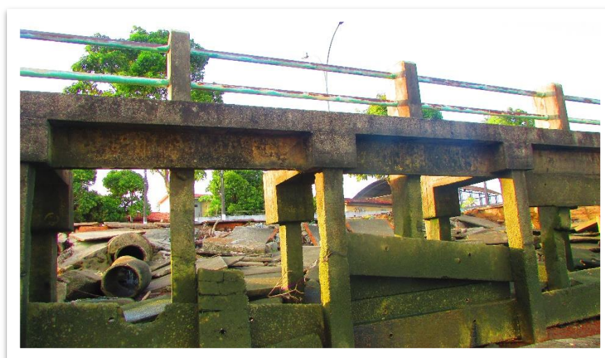
Figura 53 - Deslocamento dos pré-moldados
