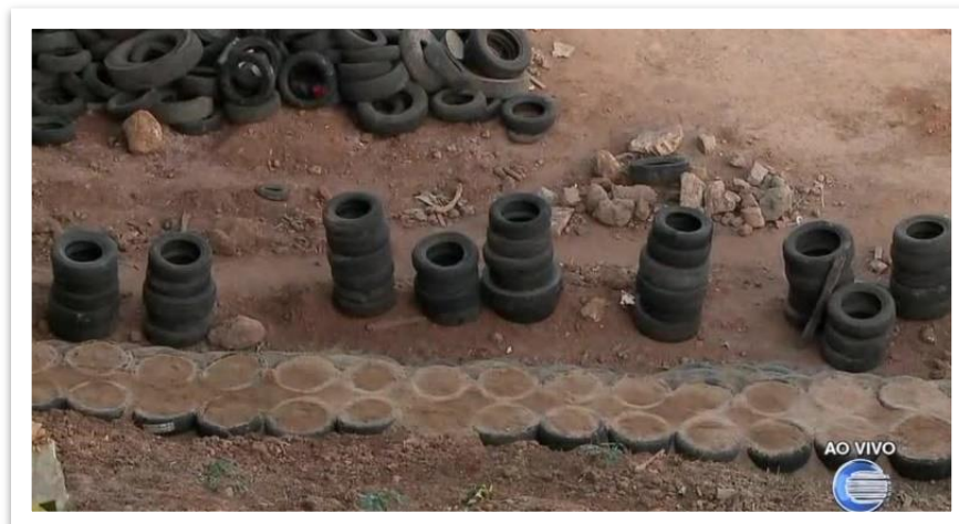
Figura 2 - Sistema de contenção com pneus sob a ponte Wall Ferraz (Piauí)
