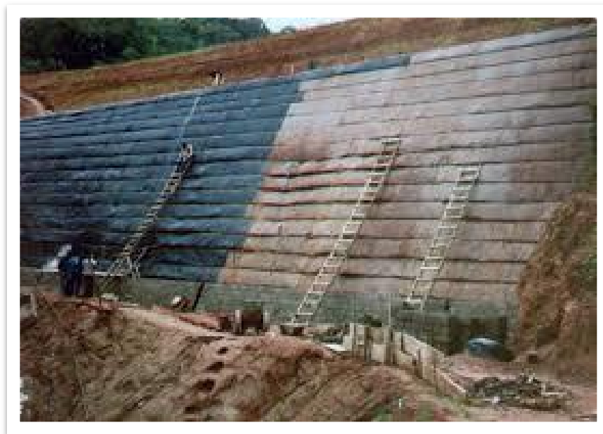
Figura 11 - Primeira obra de talude de solo reforçado com geossintéticos realizado em 1986 na SP-123
