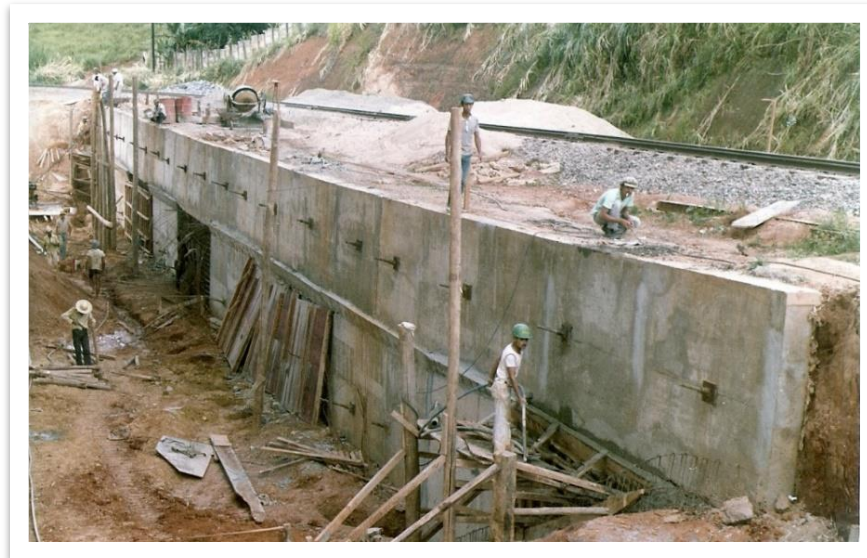
Figura 9 - Execução de muro atirantado
