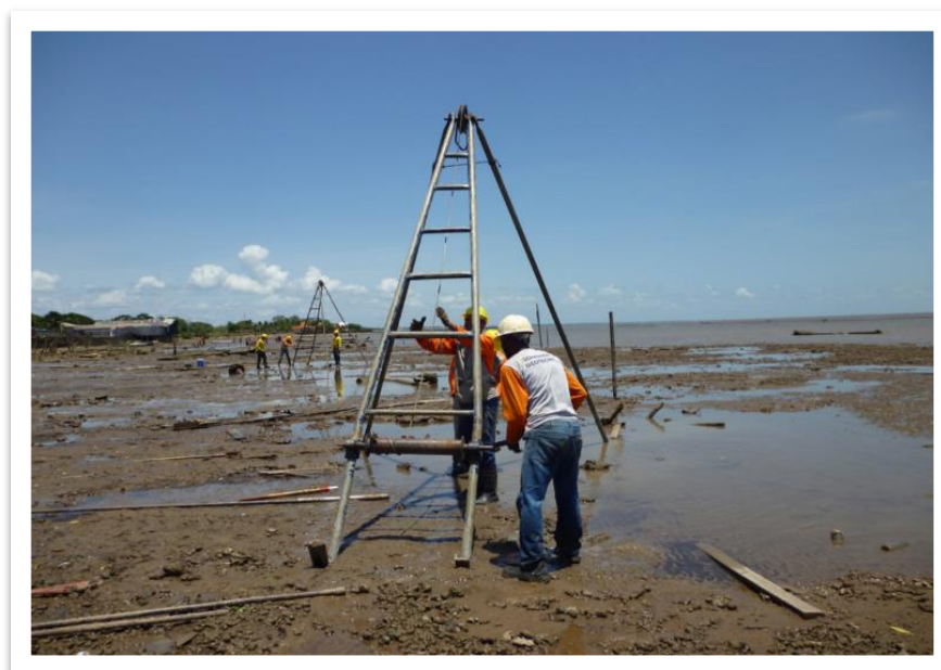
Figura 39 - Realização das sondagens na orla do Araxá
