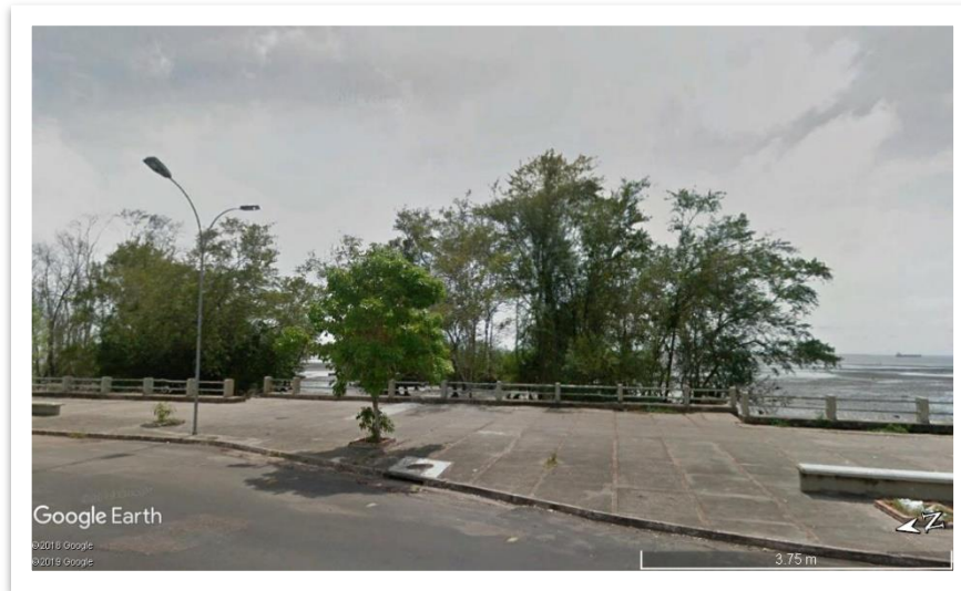
Figura 28 - Trecho do muro em estudo – Imagem de 2012
