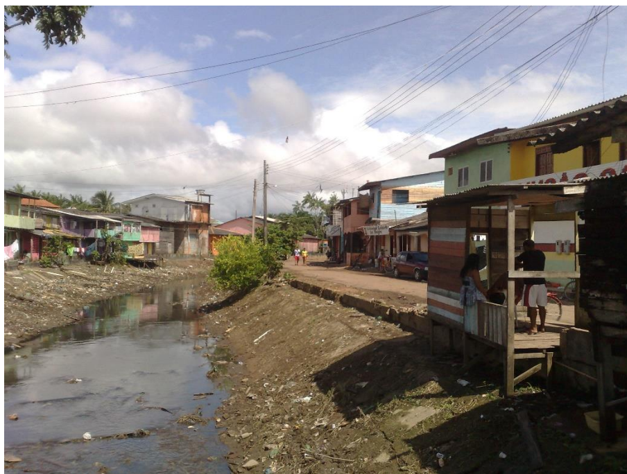
Figura B2 - Canal do bairro Perpétuo Socorro – 2007
