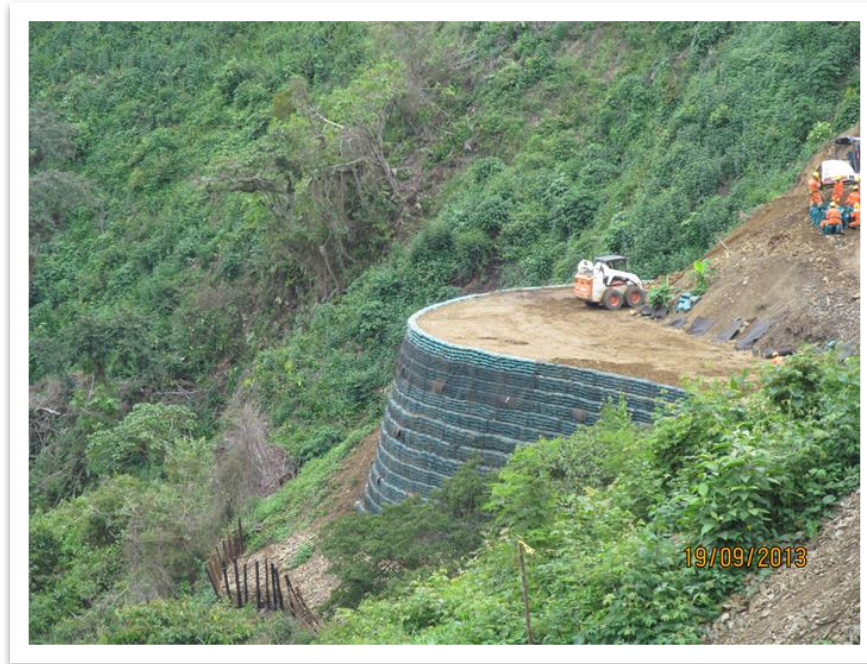
Figura 12 - Muro de 9m em solo reforçado nas montanhas de Antioquia, Colômbia
