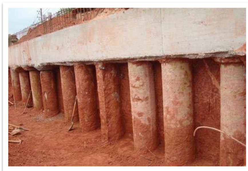
Figura 8 - Cortina de estacas espaçadas
