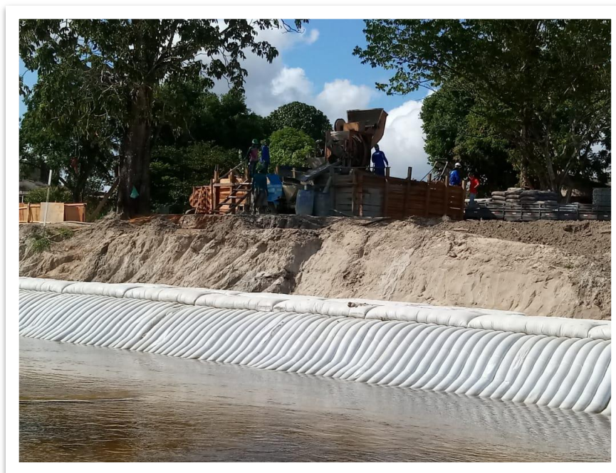
Figura 6 – Construção do muro de arrimo com sistema Bolsacreto – Município de Tartarugalzinho/AP
