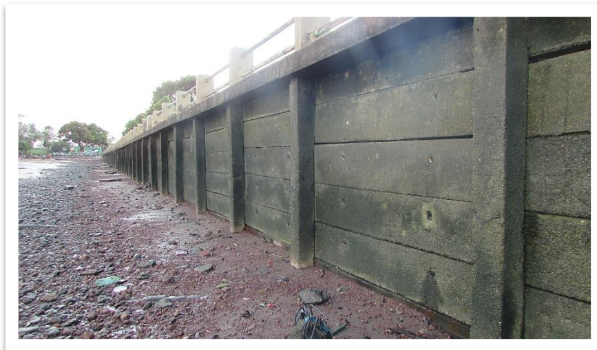
Figura 29 - Vista frontal do muro com placas pré-moldadas - Orla do Perpétuo Socorro
