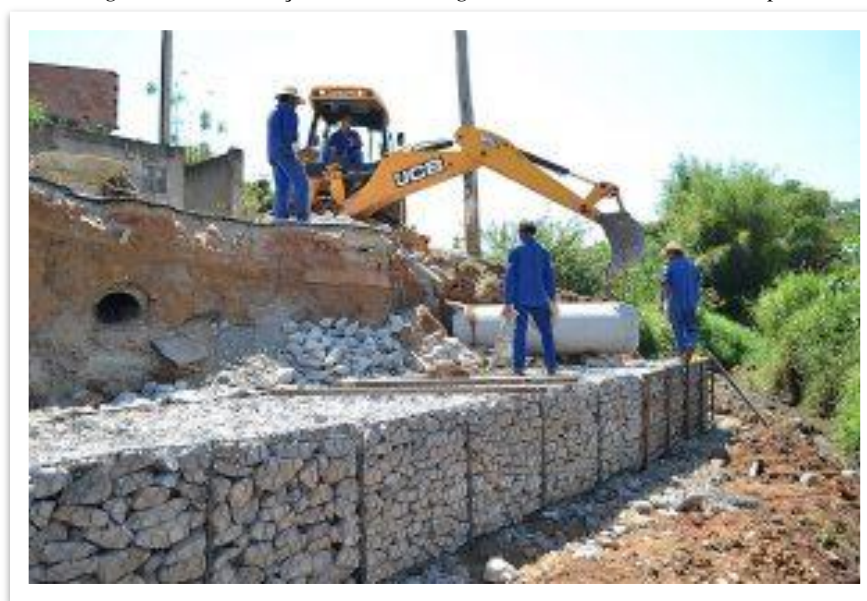
Figura 3 - Construção de muro de gabião em São José dos Campos
