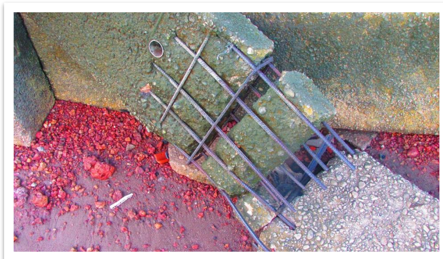
Figura 35 - Armadura de uma das placas pré-moldadas
