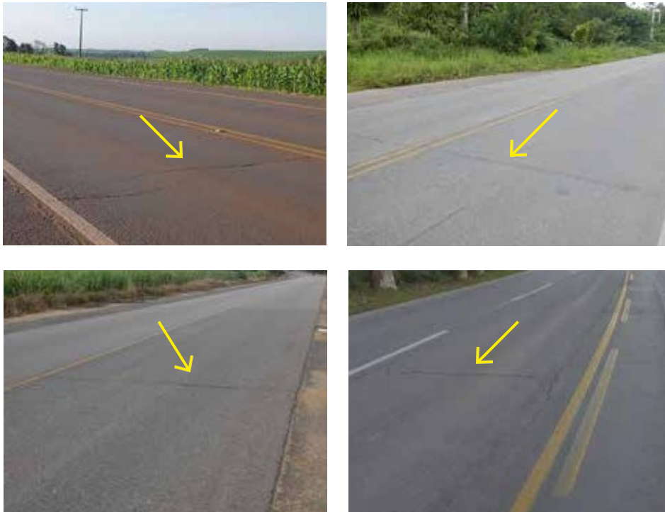
Figura 10: Trinca transversal
