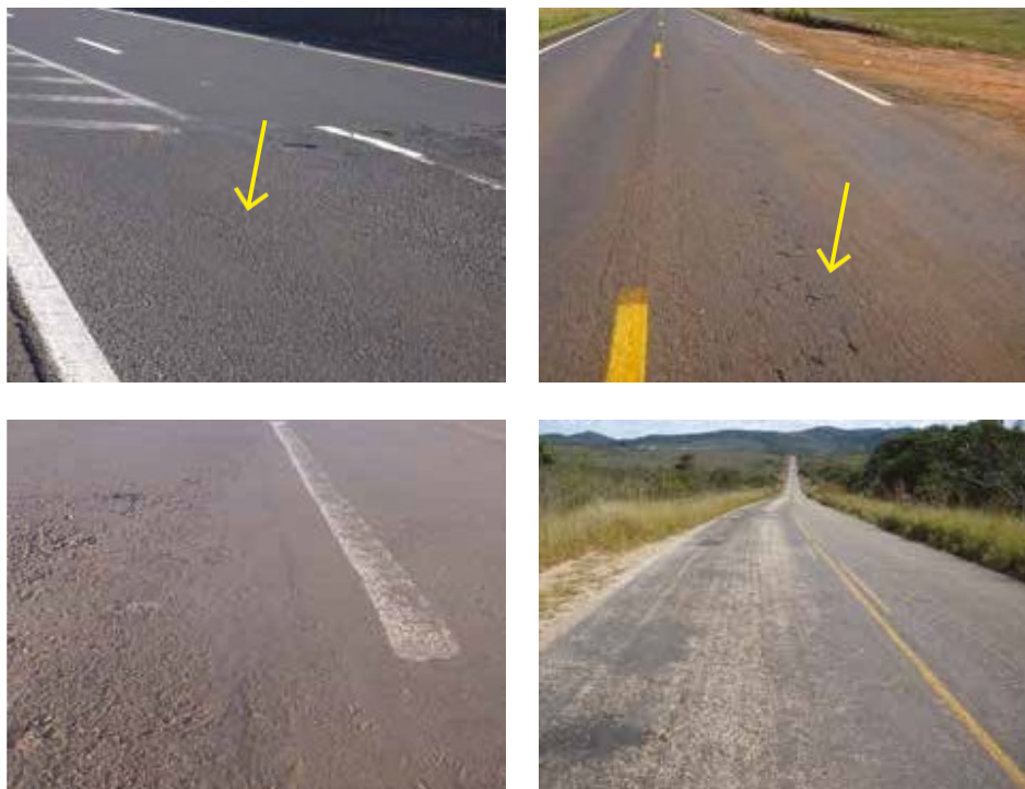
Figura 22: Desgaste
