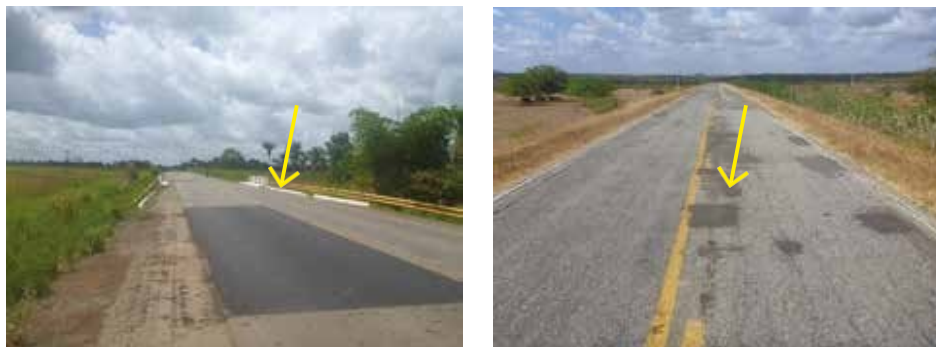
Figura 24: Remendo
