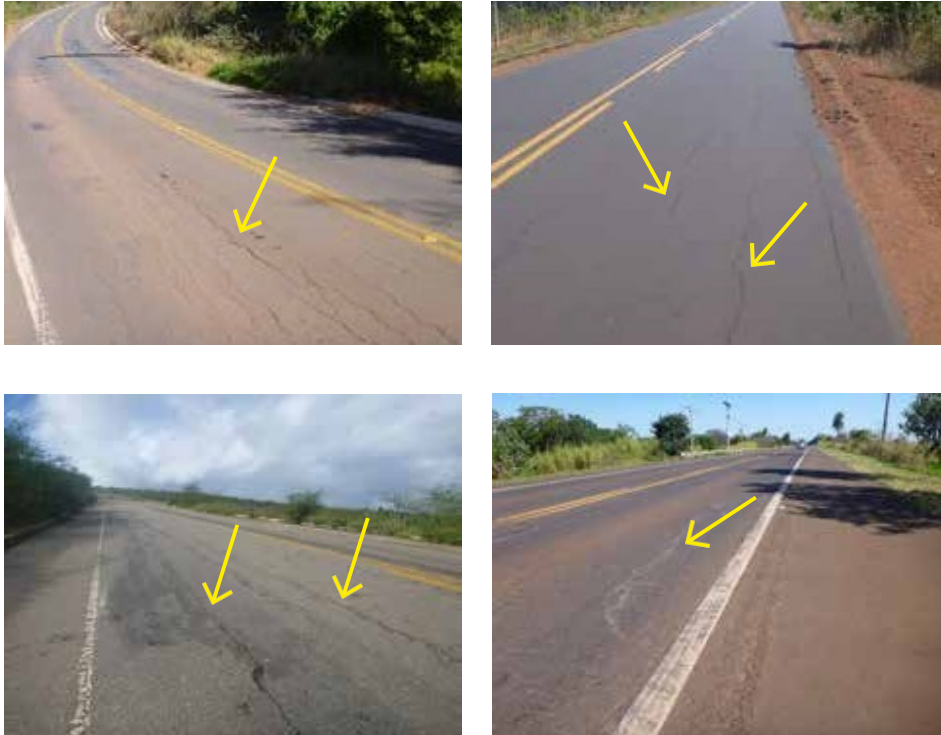
Figura 11: Trinca longitudinal
