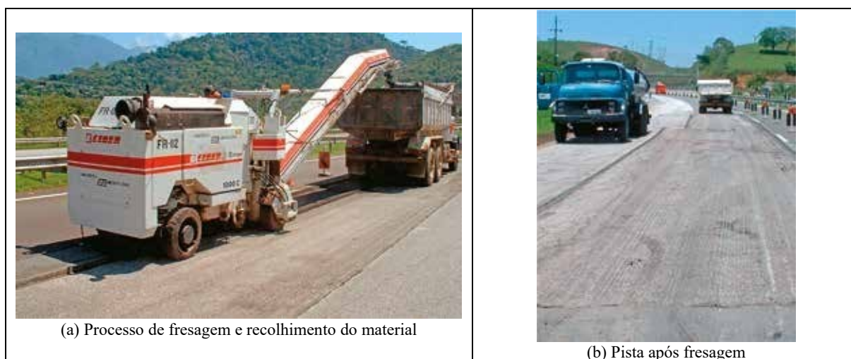
Figura 36: Exemplo de fresadora e de serviço de fresagem em uma rodovia
