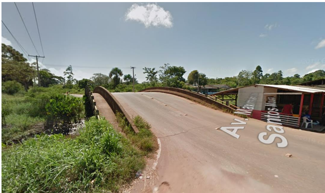
Figura 14 - Ponte do Canal do Jandiá.
