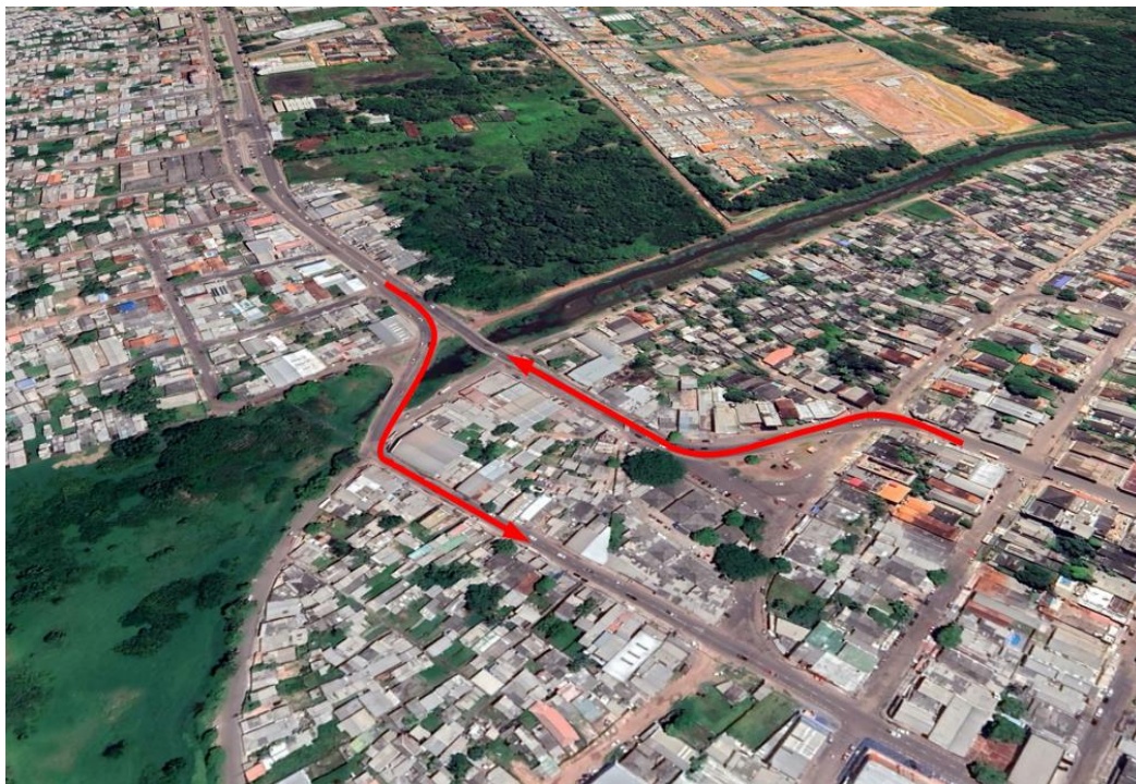
Figura 10 - Fluxos de tráfego local na Ponte Sérgio Arruda e proximidades.
