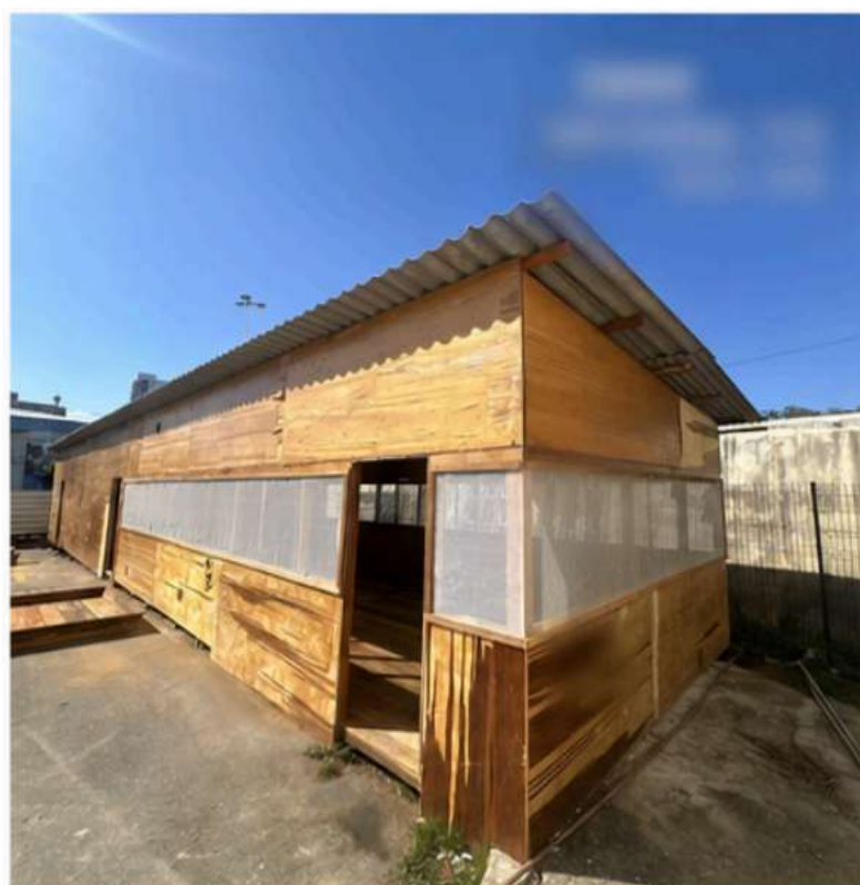
Figura 23 - Refeitório construído com madeira reaproveitada no canteiro de obras.
