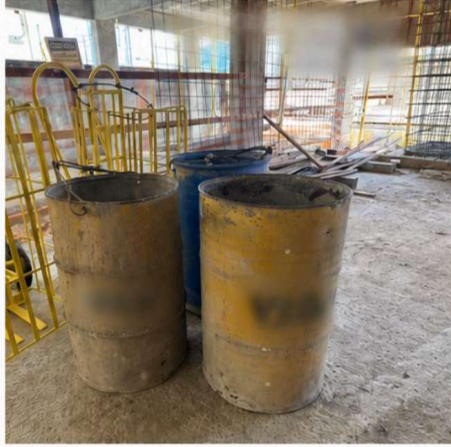
Figura 26 - Bombonas utilizadas para segregação de resíduos menores na Empresa 1
