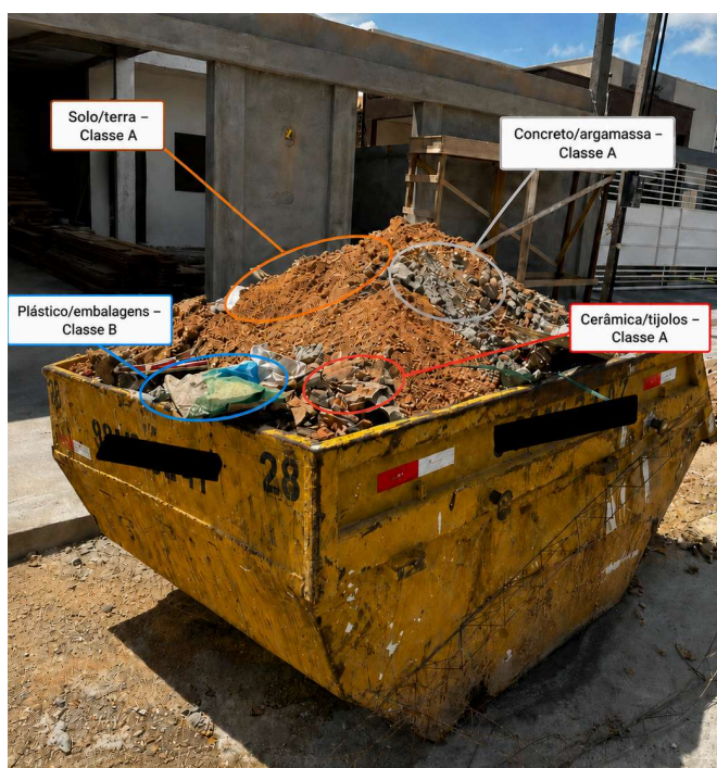
Figura 5 - Caçamba estacionária utilizada para acondicionamento de RCC em obra residencial.
