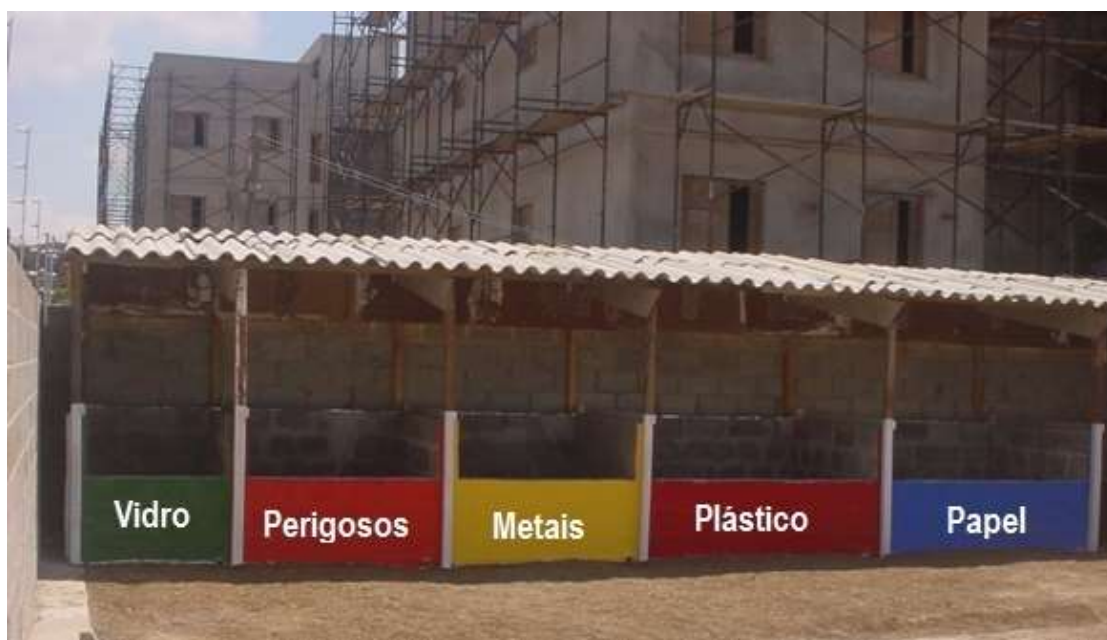
Figura 6 - Ilha de triagem para segregação de resíduos em canteiro de obras
