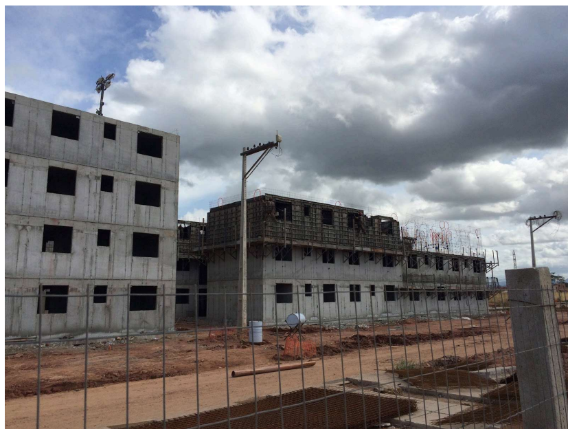
Figura 8 - Execução de paredes de concreto moldadas in loco com fôrmas de alumínio
