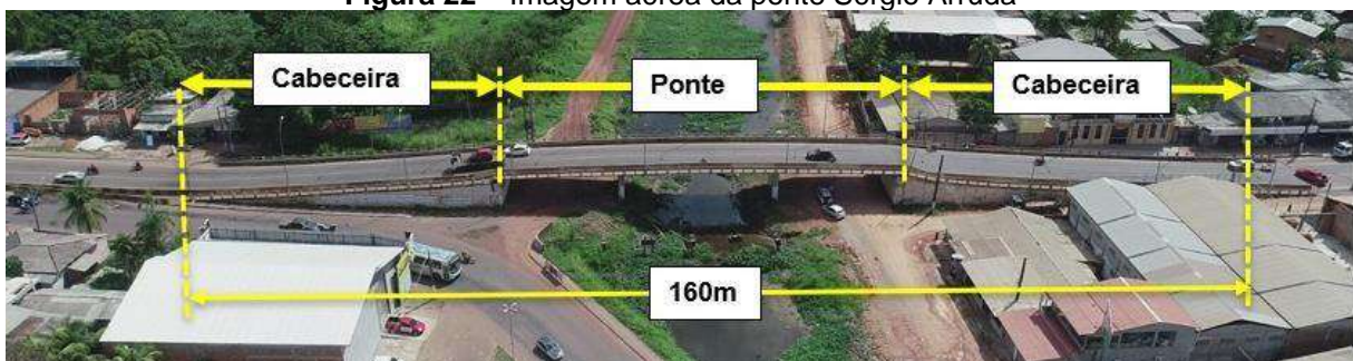
Figura 22 – Imagem aérea da ponte Sérgio Arruda
