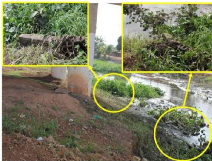
Figura nº 08: Mostra de resquício de muro de contenção.
