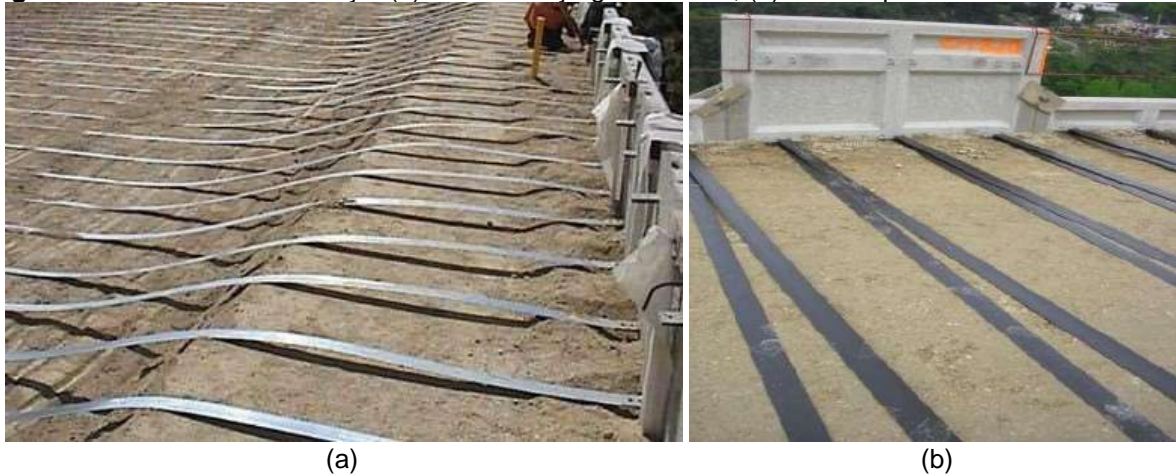
Figura 3 – Elementos de reforço: (a) Tiras em aço galvanizado; (b) Fios de poliéster de alta aderência
