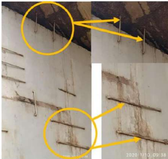
Figura nº 10: Mostra os grampos aplicados nas duas estruturas - cabeceira e tabuleiro.
