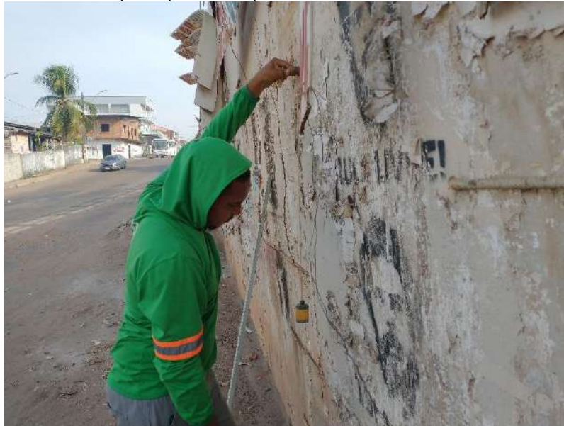
Figura 32 – Medição a prumo do perfil de deslocamento na cabeceira norte
