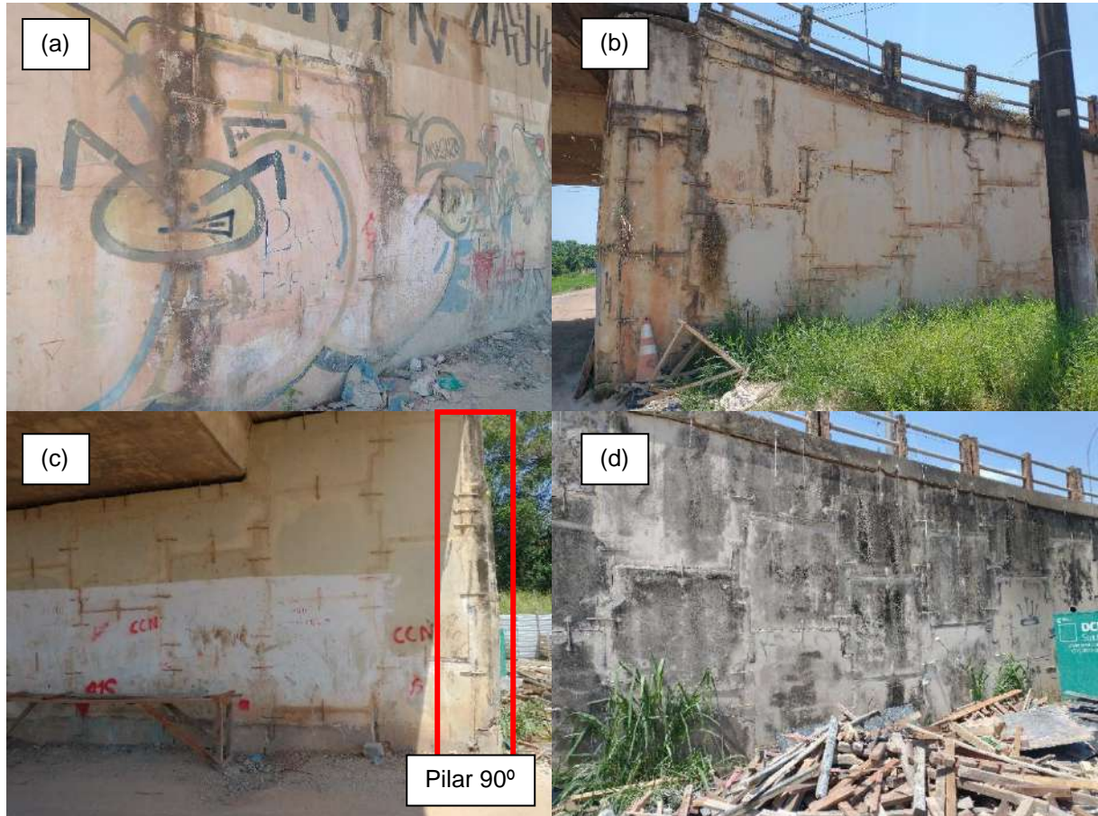
Figura 35 – Região dos acessos com grampos e fechamento das juntas: (a) e (b) Lado Sul; (c) e (d) Lado Norte
