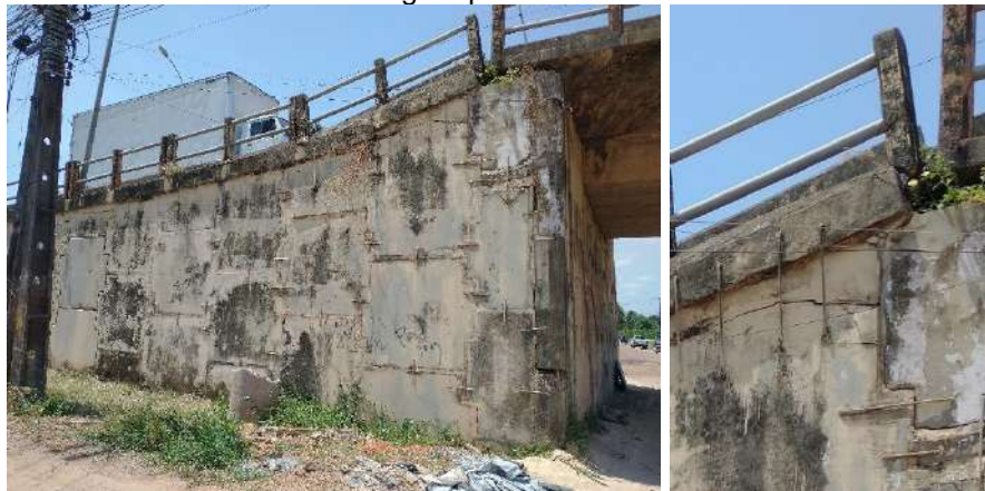
Figura 24 – (a) Cabeceira Sul em trecho com grampos e juntas fechadas (b) Vista ampliada do grampeamento
