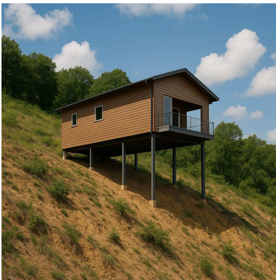
Figura 12 – Casa sobre pilotis
