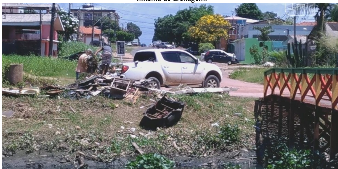
Figura 11: Disposição irregular em canal de Macapá que contribui para poluição ambiental e pode prejudicar o sistema de drenagem.
