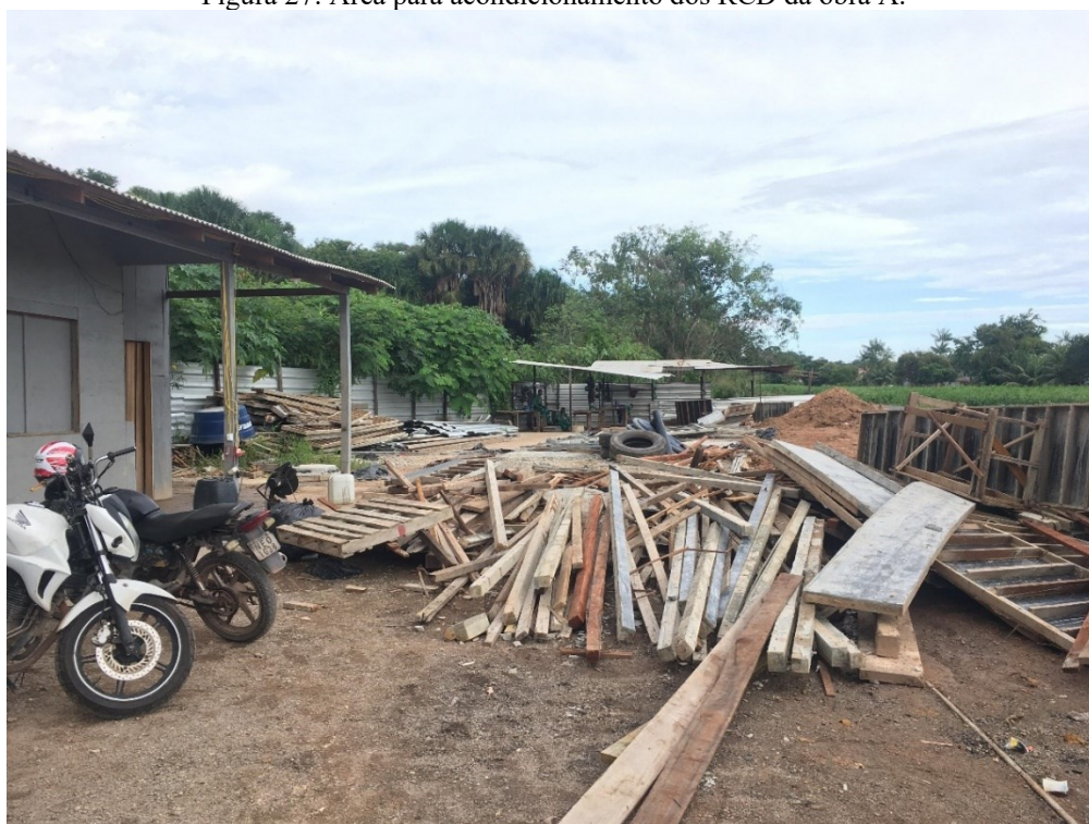
Figura 27: Área para acondicionamento dos RCD da obra A.
