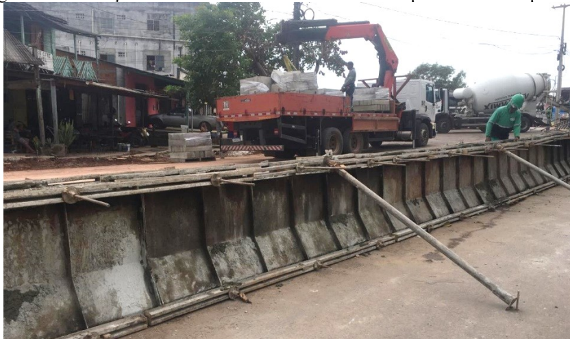
Figura 43: Utilização de formas e escoramentos metálicos para barreira de proteção.
