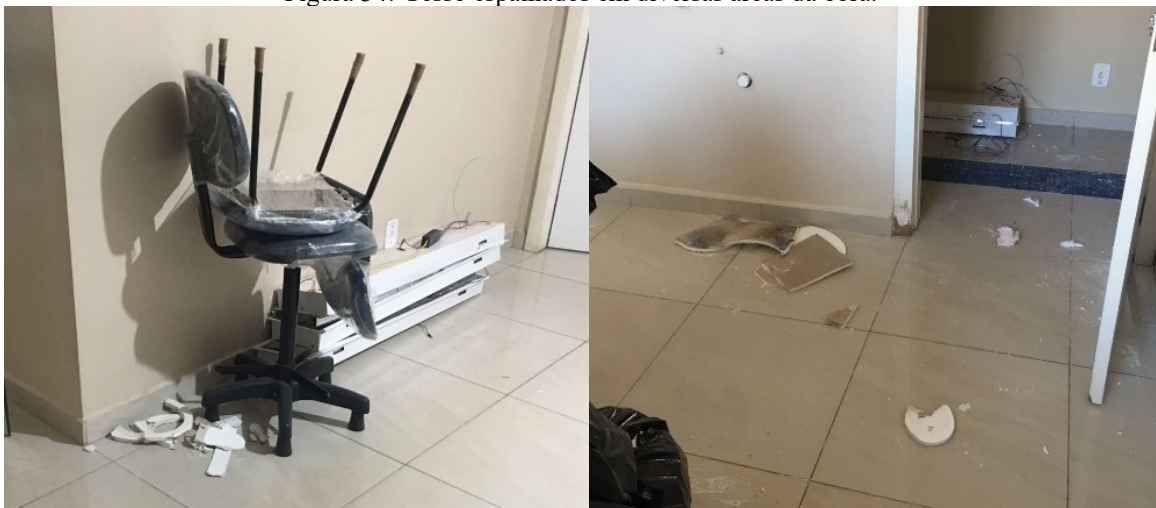
Figura 34: Gesso espalhados em diversas áreas da obra.
