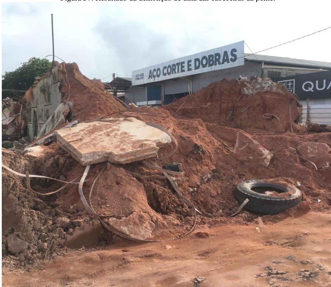
Figura 37: Resultado da demolição de uma das cabeceiras da ponte.
