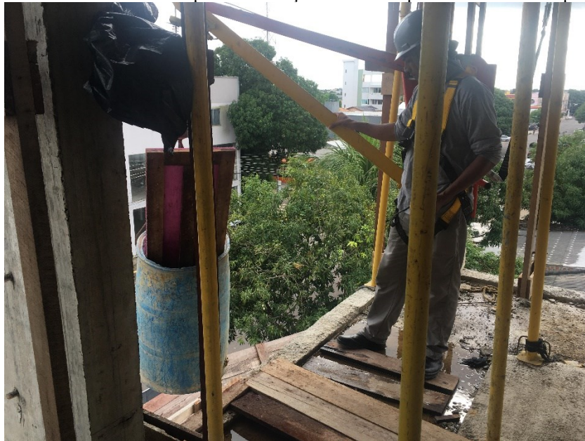
Figura 41: Forma de madeira para reutilização sendo transportada em balde de plástico.
