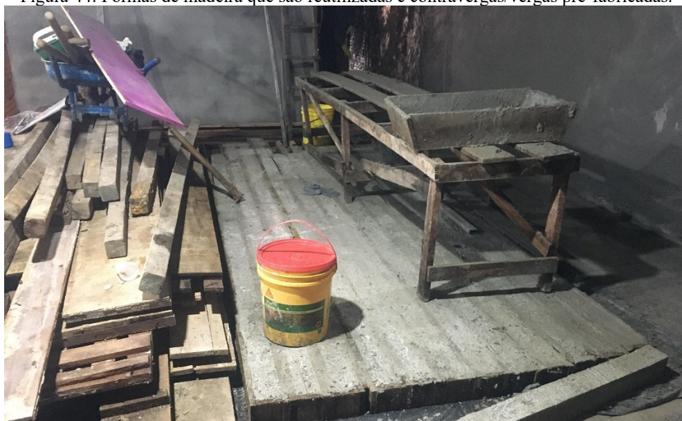
Figura 44: Formas de madeira que são reutilizadas e contravergas/vergas pré-fabricadas.
