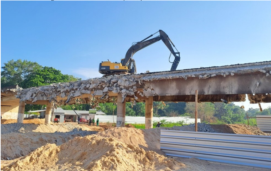
Figura 23: Processo de demolição da ponte com escavadeira hidráulica.
