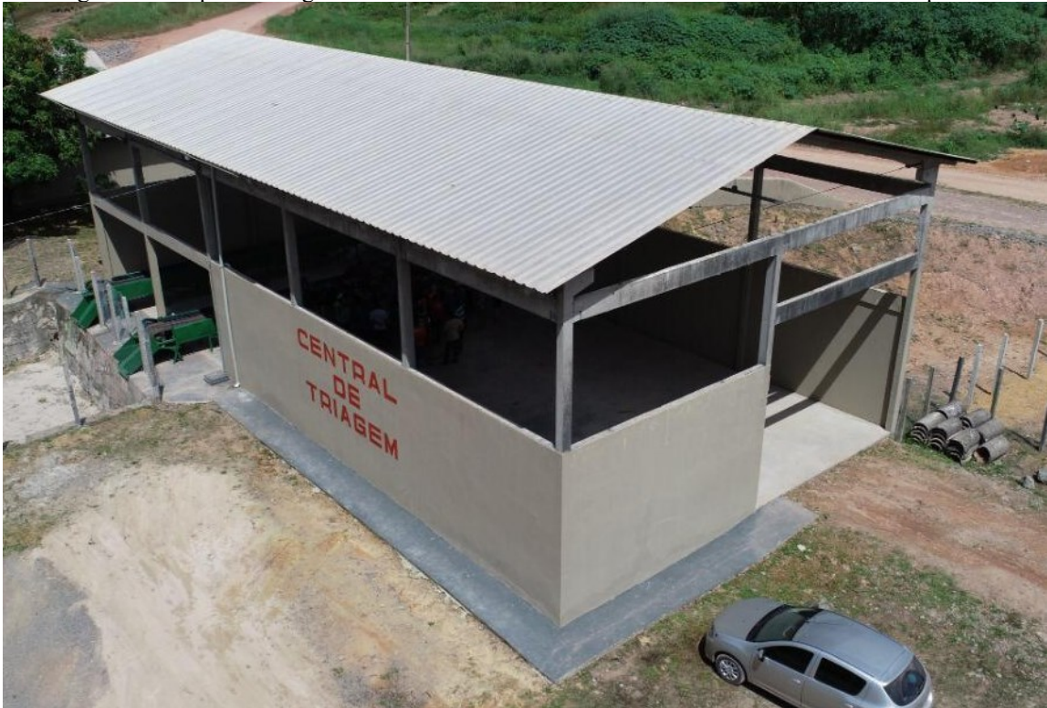
Figura 16: Galpão de triagem sem funcionamento localizado no Aterro sanitário de Macapá/AP.
