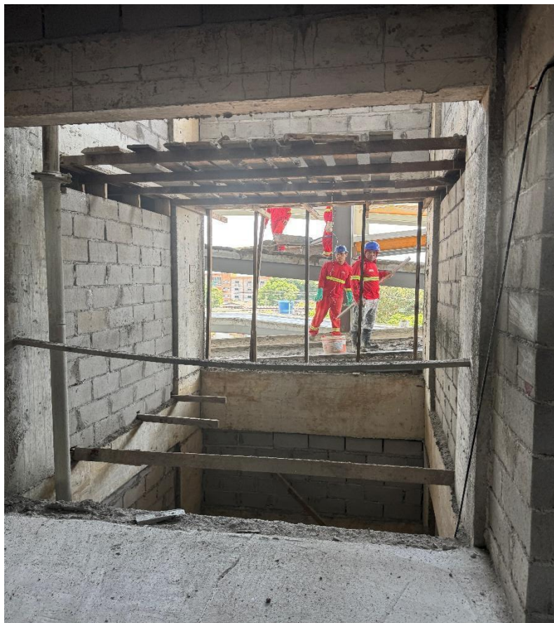
Figura 5 – Imagem do local da construção do Novo Hospital de Emergência
