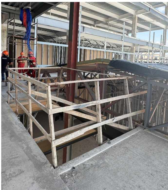
Figura 4 – Imagem de vão na obra
