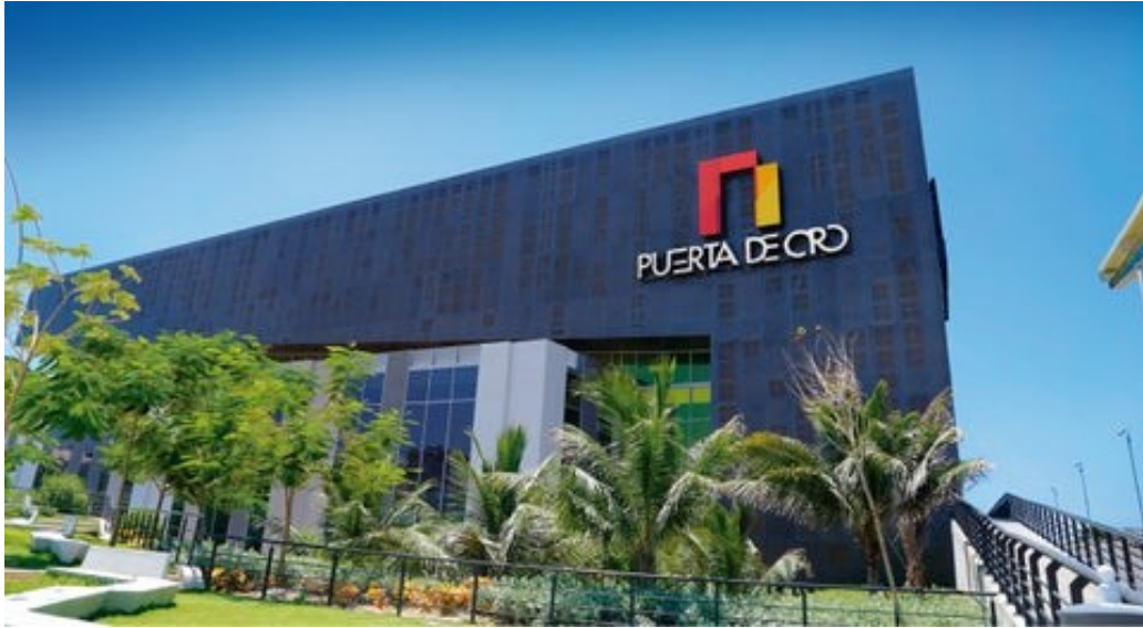
Figura 22 - Centro de eventos Puerta de Oro, localizado em Barranquilla na Colômbia
