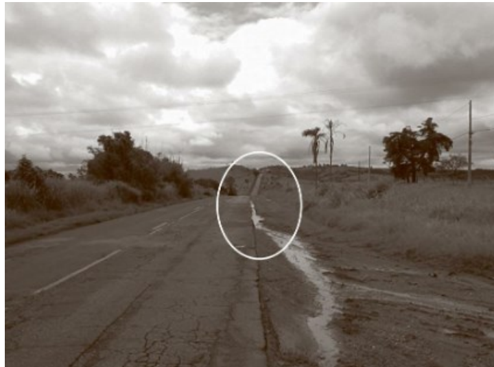
Figura 12 - Acostamento sem revestimento, com canal de escoamento ao longo da superfície da pista
