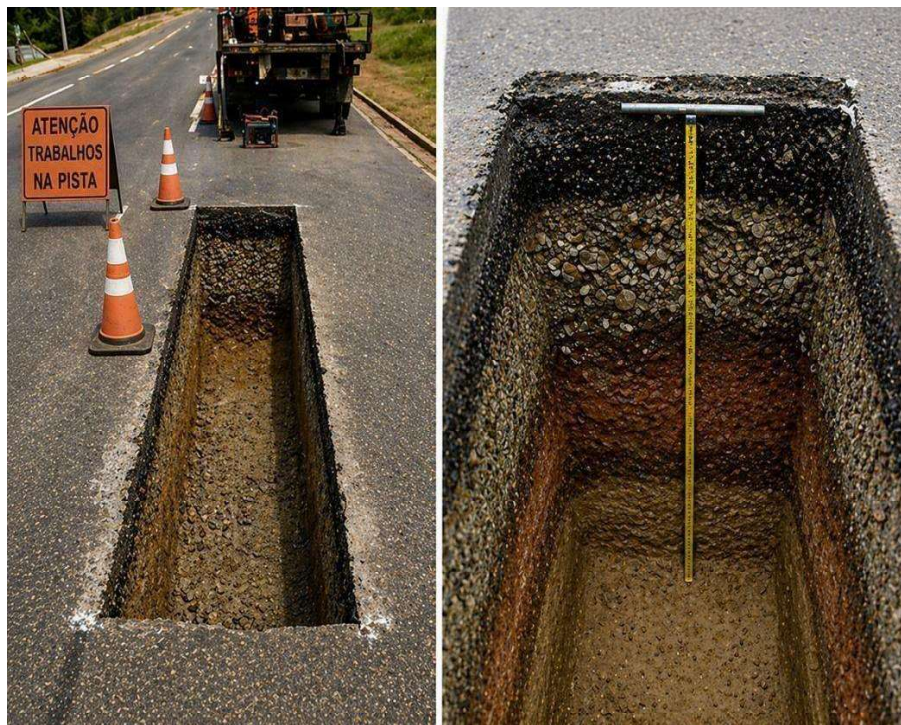
Figura 8 - Abertura de trincheira para inspeção de pavimento
