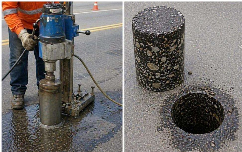
Figura 7 - Extração de corpo e prova em pavimento asfáltico
