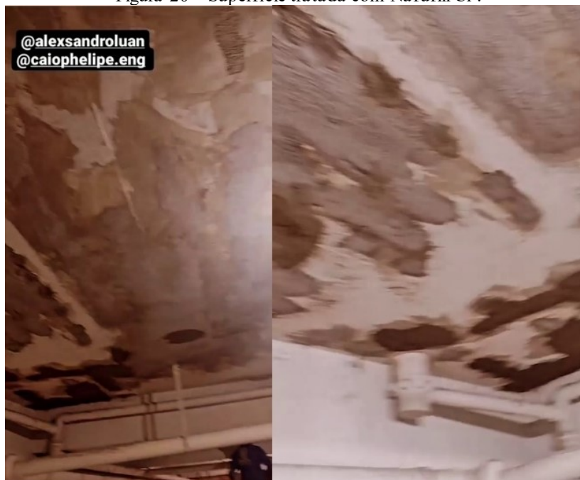
Figura 20 – Superfície tratada com Nafufill Cr.
