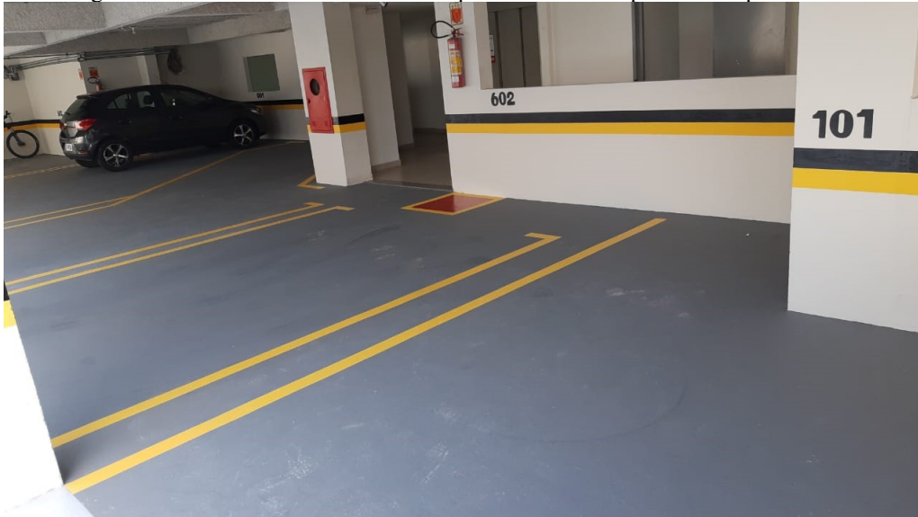
Figura 27 - Pintura finalizada com o impermeabilizante epóxi com o poliuretano
