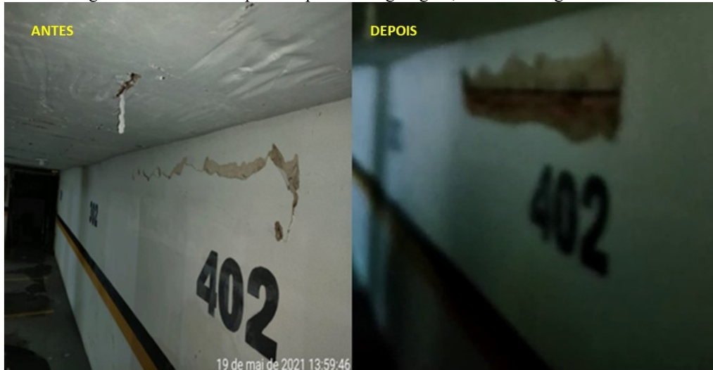
Figura 57 - Antes e Depois da parede da garagem, visto na imagem anterior
