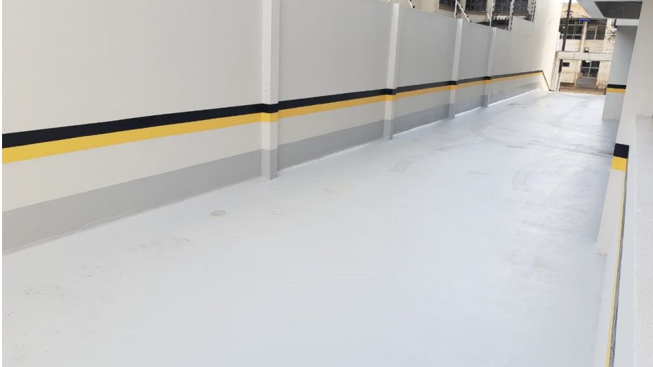
Figura 26 - Pintura finalizada com o impermeabilizante epóxi com o poliuretano
