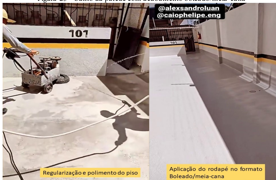
Figura 23 - Canto da parede com acabamento boleado/meia-cana
