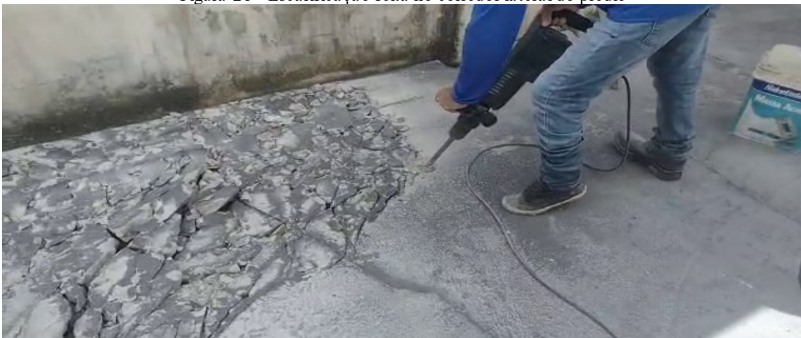
Figura 21 - Escarificação feita no corredor lateral do prédio
