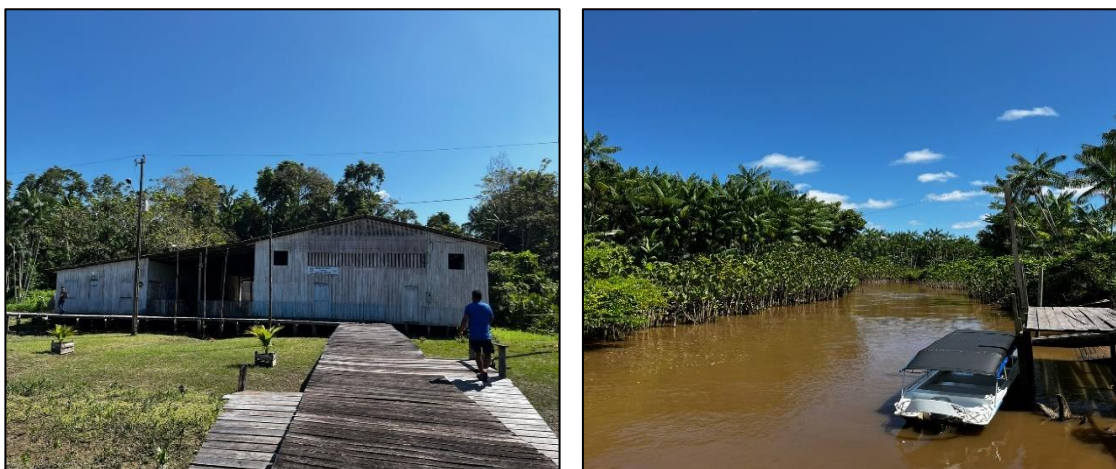
Figuras 13 e 14 – Vista frontal da E. E. Leandro Plácido Ferreira: fluvial e de um dos portos de acesso.
