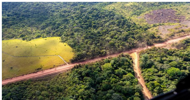
Figura 14 - BR-156/AP – Trecho não pavimentado
