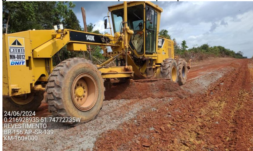
Figura 10 - Processo de manutenção – Compactação com motoniveladora
