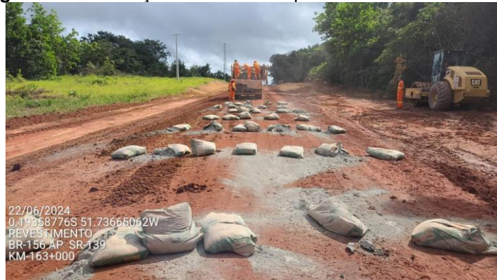
Figura 7 - Manutenção de trecho não pavimentado na BR- 156/AP
