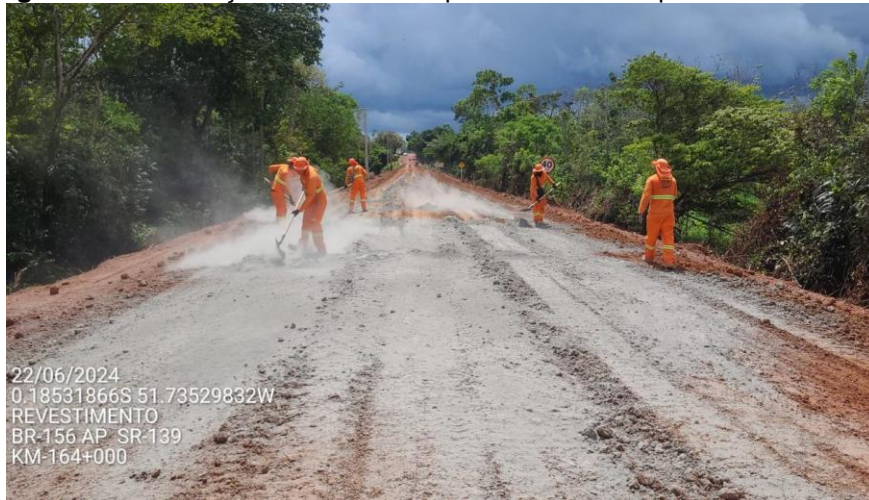
Figura 8 - Manutenção de trecho não pavimentado – Espalhamento manual
