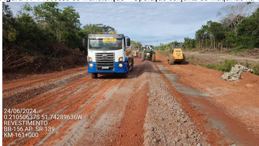
Figura 11 - Processo de manutenção – Operação conjunta de máquinas na via
