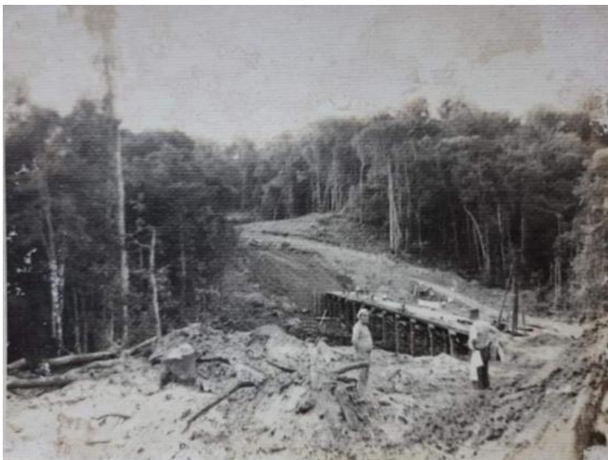
Figura 3 – Trabalhadores nas primeiras frentes de obra da BR-156
