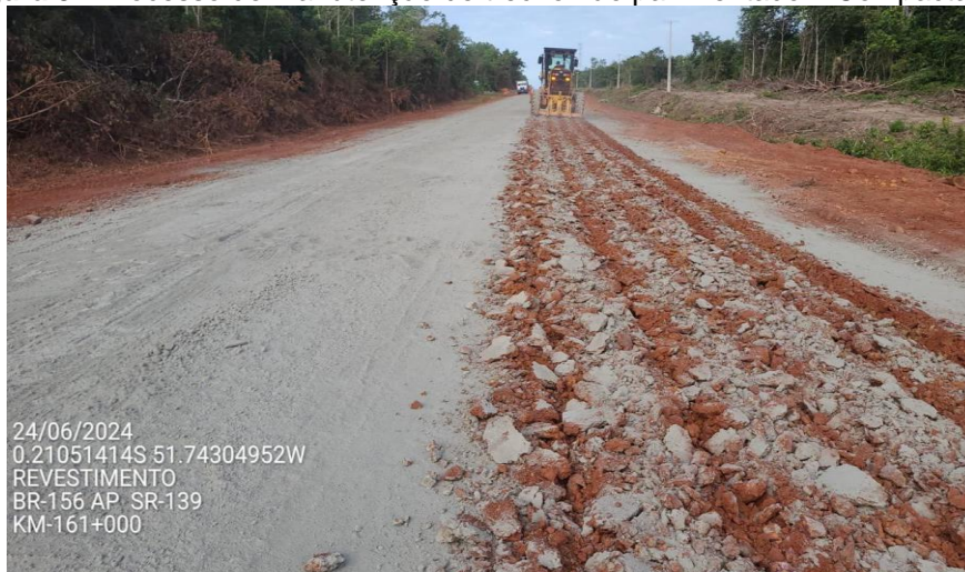
Figura 9 - Processo de manutenção de trecho não pavimentado – Compactação.
