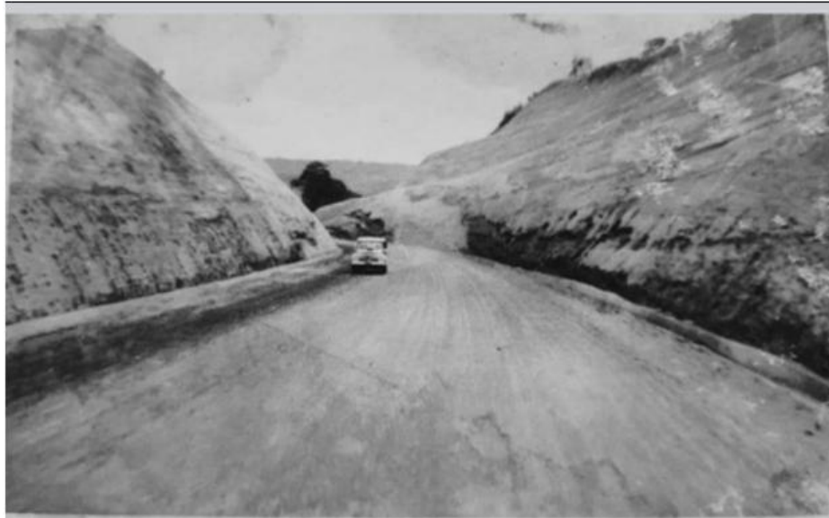
Figura 6 – Trecho da BR-156/AP em área de cortes de taludes
