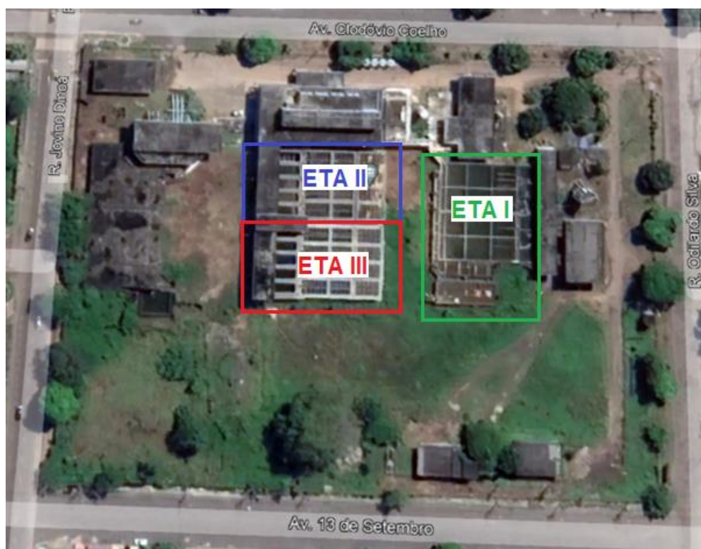
Figura 6: Localização dos módulos de tratamento (ETA 1, 2 e 3) na ETAM
