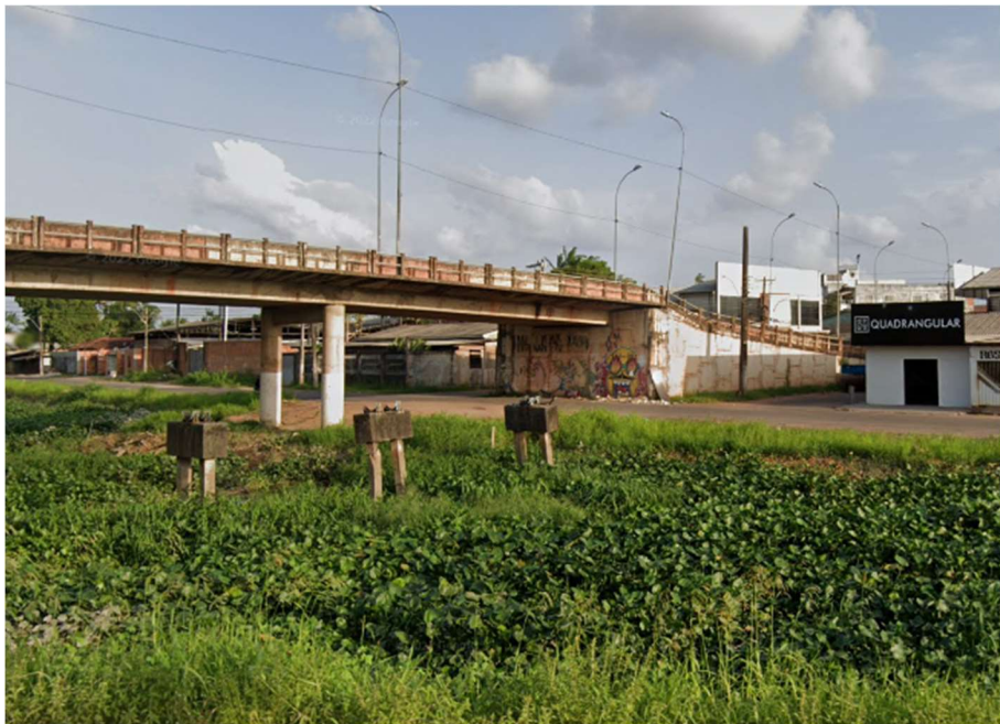
Figura 49 – Elevação frontal seção do trecho do talude de estudo.
