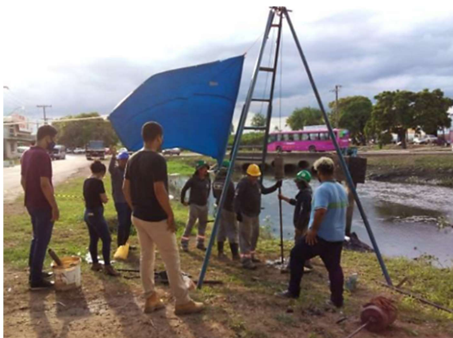
Figura 33 – Registro de realização do ensaio SPT, furo 3.
