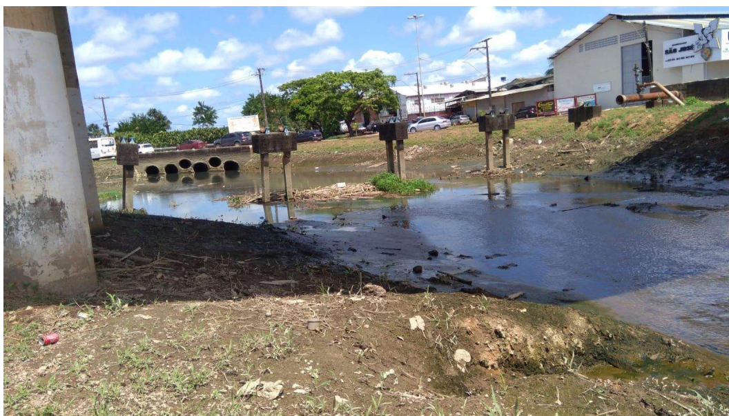
Figura 63 – Registro fotográfico imediações da PSA – cabeceira sul com canal em vazante.
