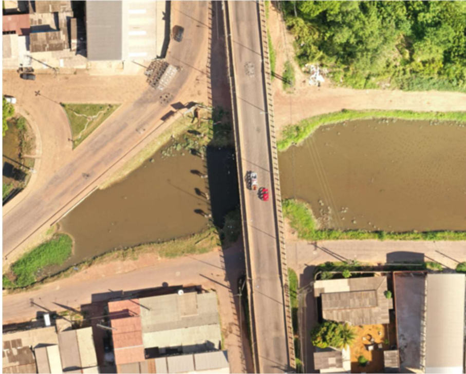
Figura 48 – Vista em planta do talude de estudo.
