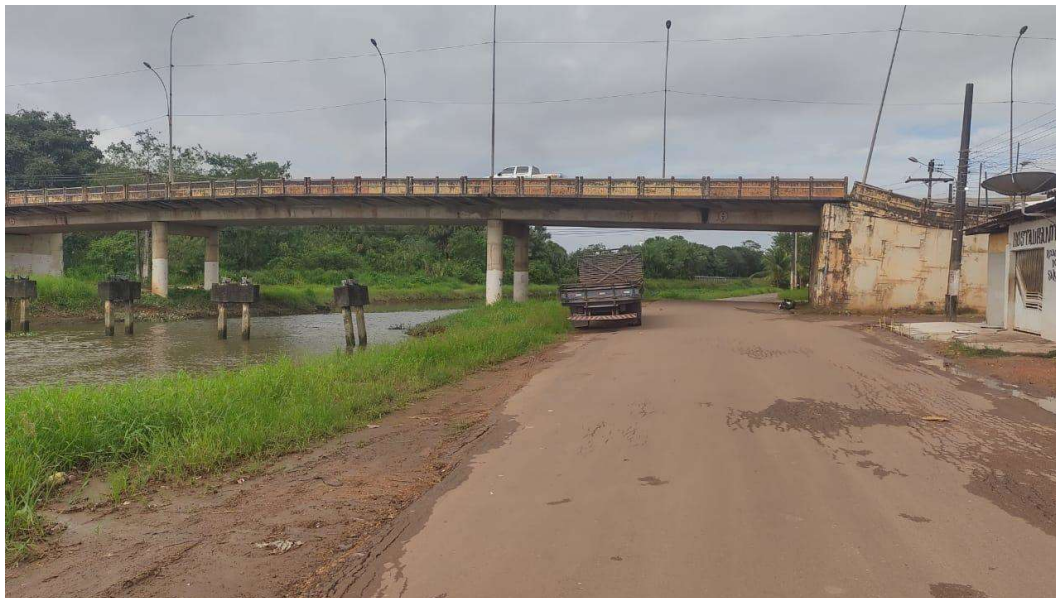
Figura 62 – Registro fotográfico imediações da PSA – cabeceira sul.
