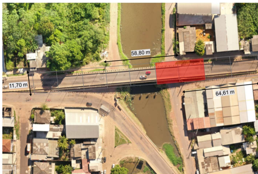
Figura 67 – Demarcação da área de influência considerada para estimativa de sobrecargas – conforme geometria da atual PSA.
