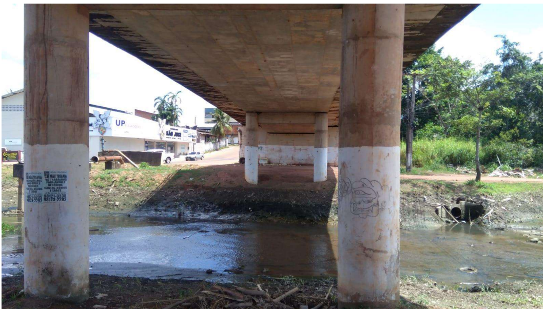
Figura 65 – Registro fotográfico imediações da PSA – encosta nas proximidades da cabeceira sul.
