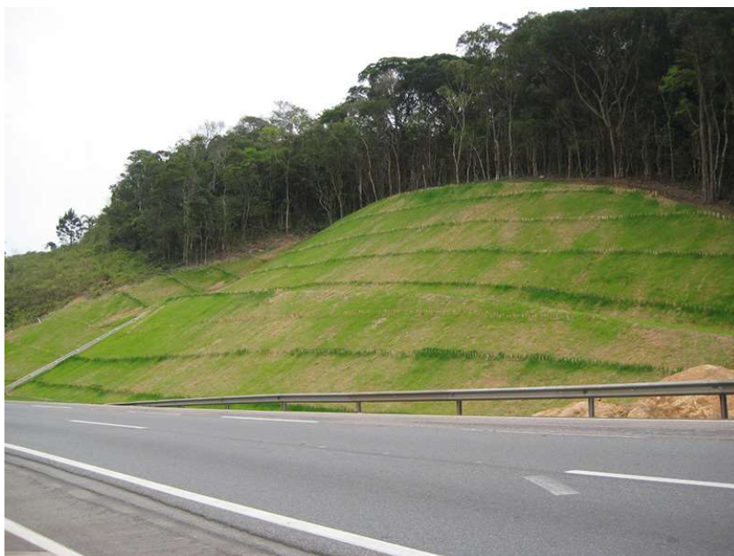
Figura 29 – Técnicas de estabilização de talude: revestimento superficial.
