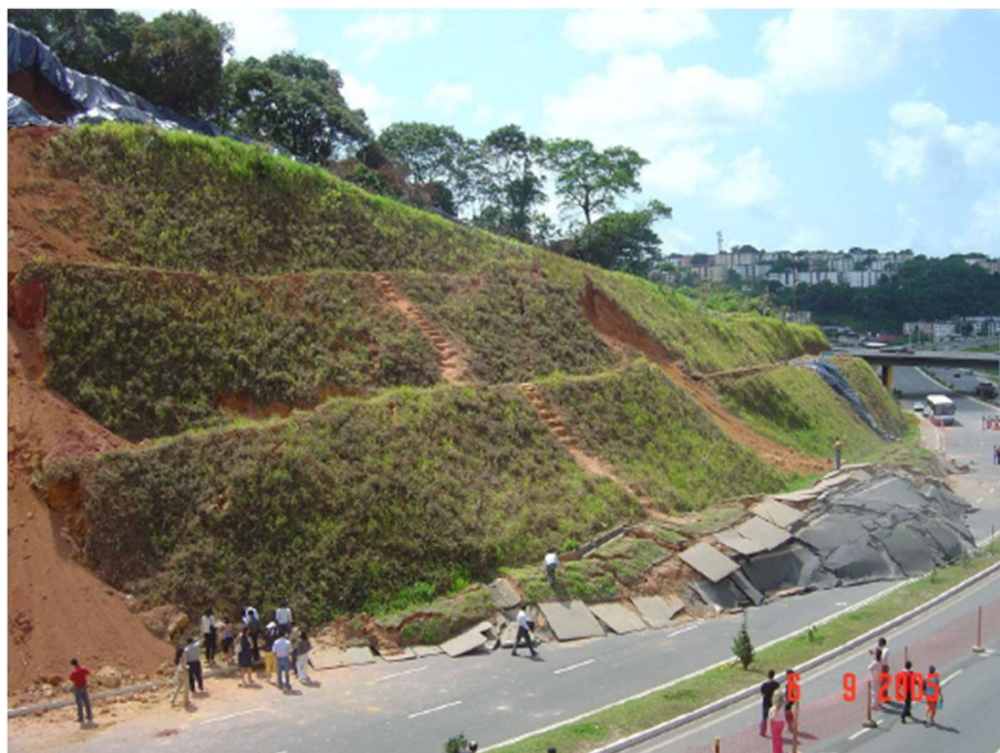
Figura 13 – Exemplificação das feições usuais de um talude instável.
