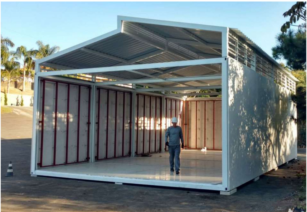
Figura 5: Montagem de estrutura modular
