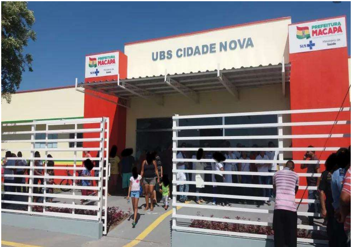
Figura 19: Fachada frontal da UBS Cidade Nova
