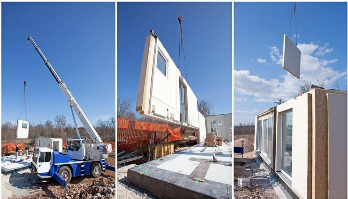
Figura 4: Etapas de montagem de uma edificação modular
