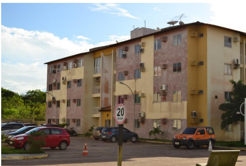
Figura 33 - Edifício D do condomínio
