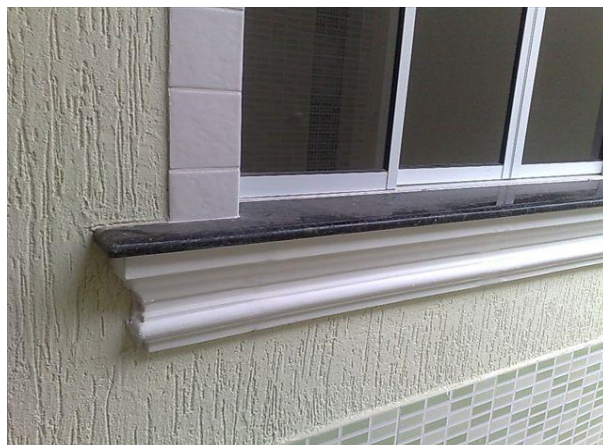
Figura 15 - Pingadeira fazendo proteção de peitoril de janela
