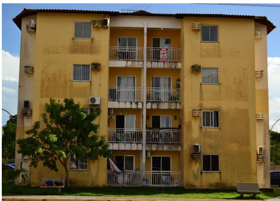
Figura 36 - Fachada lateral (B) do Edifício D
