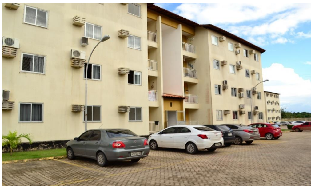
Figura 38 - Fachada principal de entrada do Edifício I
