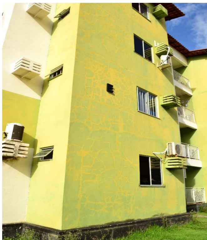
Figura 40 – Fachada lateral (A) do Edifício E
