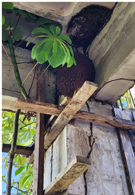
Figura 33: Proliferação de cupins no topo do pilar P18
