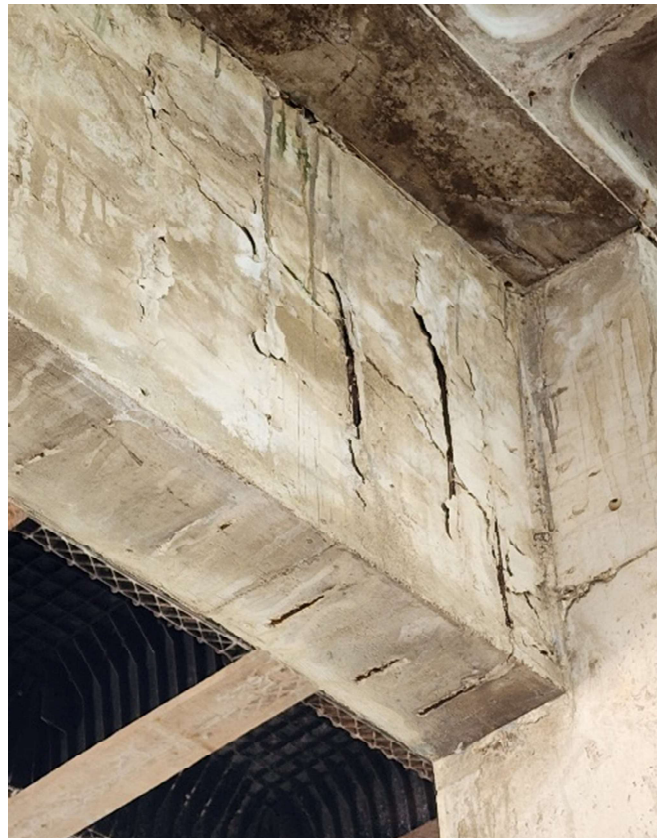
Figura 50: Viga V43 em processo inicial de deslocamento
