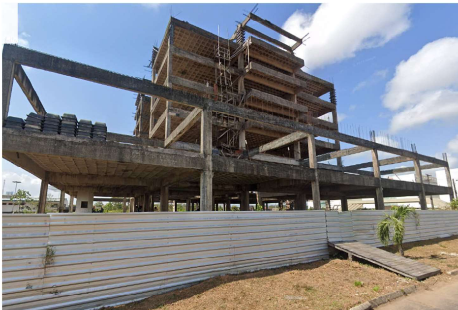
Figura 22: Fachada da edificação
