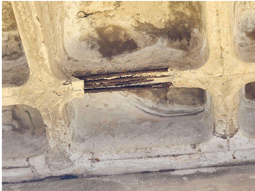
Figura 35: Concentração de armaduras nas nervuras na laje L14
