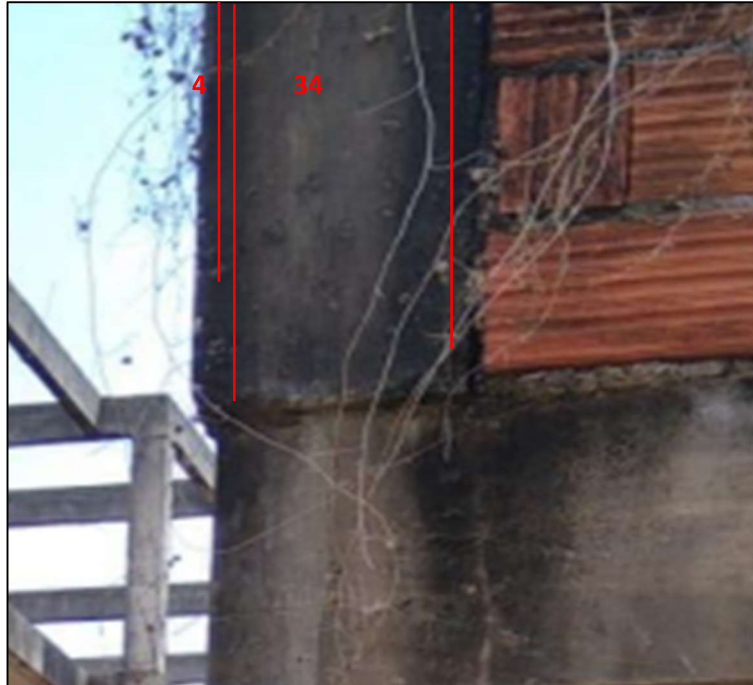
Figura 21 - Determinação do Desaprumo - P3 (15x30)
