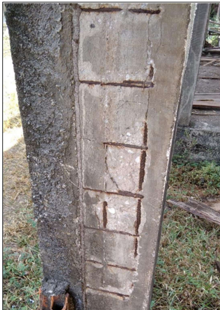
Figura 15 - Armadura Exposta
