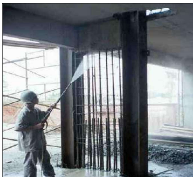
Figura 11 - Reforço por Substituição Total do Concreto
