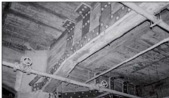
Figura 9 - Reforço por Adição de Chapa de Aço
