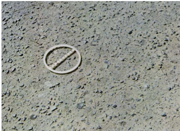
Figura 14 – Desgaste.
