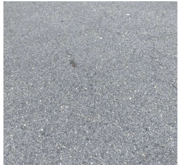
Figura 30 – Trinca Isolada Transversal Curta e Desgaste - Área de avaliação 2.
