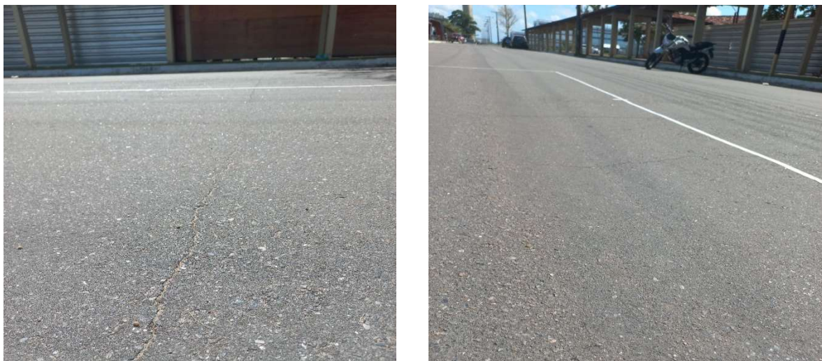
Figura 77 – Desgaste - Área de avaliação 15.
