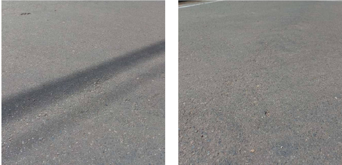
Figura 80 – Desgaste - Área de avaliação 16.
