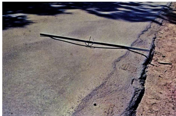
Figura 9 – Afundamento plástico - tipo trilha de roda.
