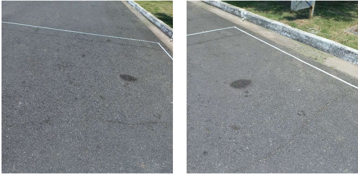
Figura 40 – Desgaste - Área de avaliação 5.
