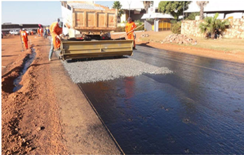
Figura 115 – Execução de Tratamento Superficial Duplo (TSD).
