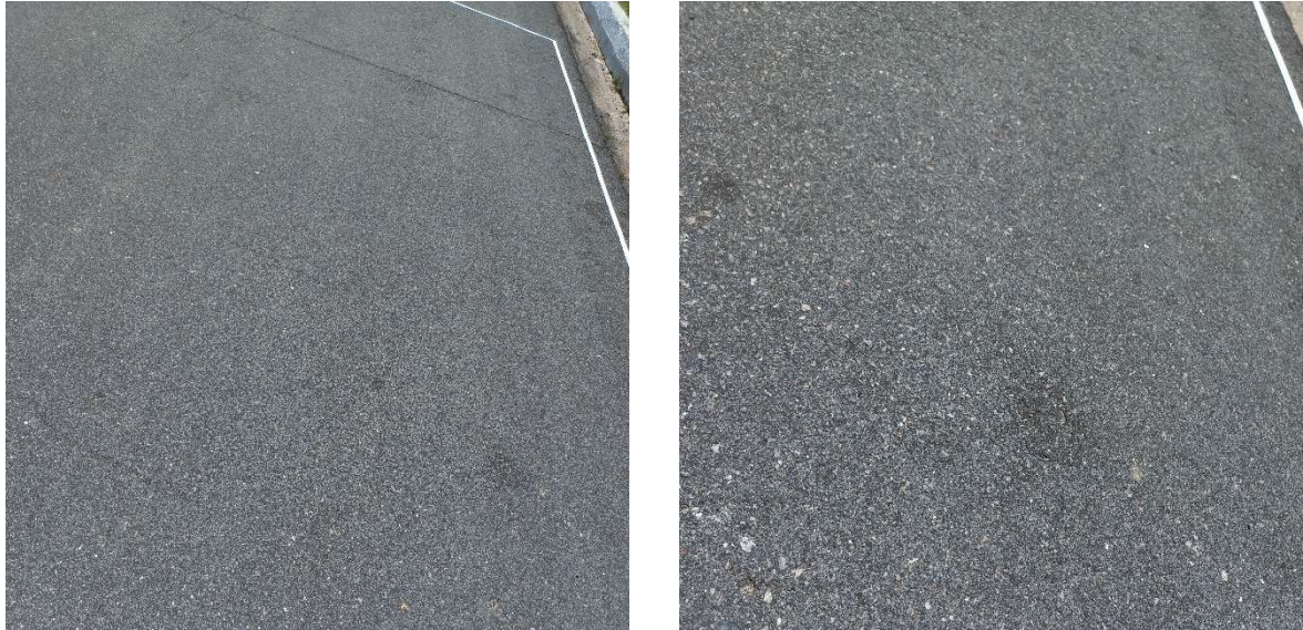
Figura 44 – Desgaste - Área de avaliação 6.
