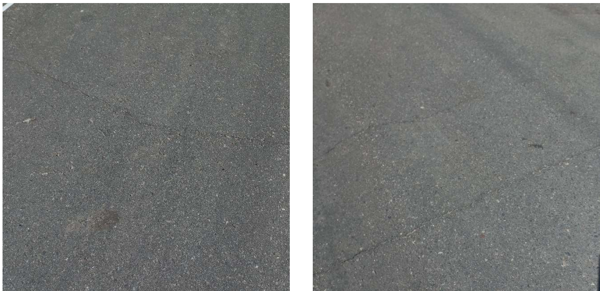
Figura 69 – Desgaste - Área de avaliação 13.
