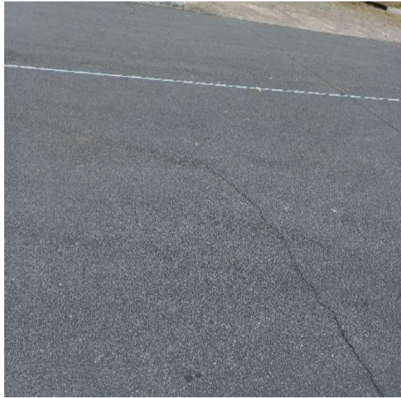
Figura 36 – Desgaste - Área de avaliação 4.
