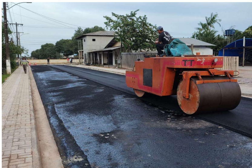
Figura 117 – Execução de Recapeamento Asfáltico.
