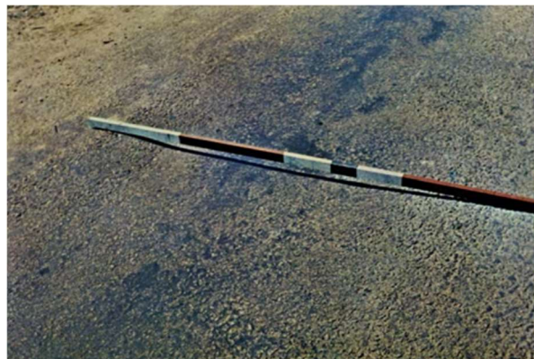
Figura 10 – Afundamento de consolidação - tipo trilha local.
