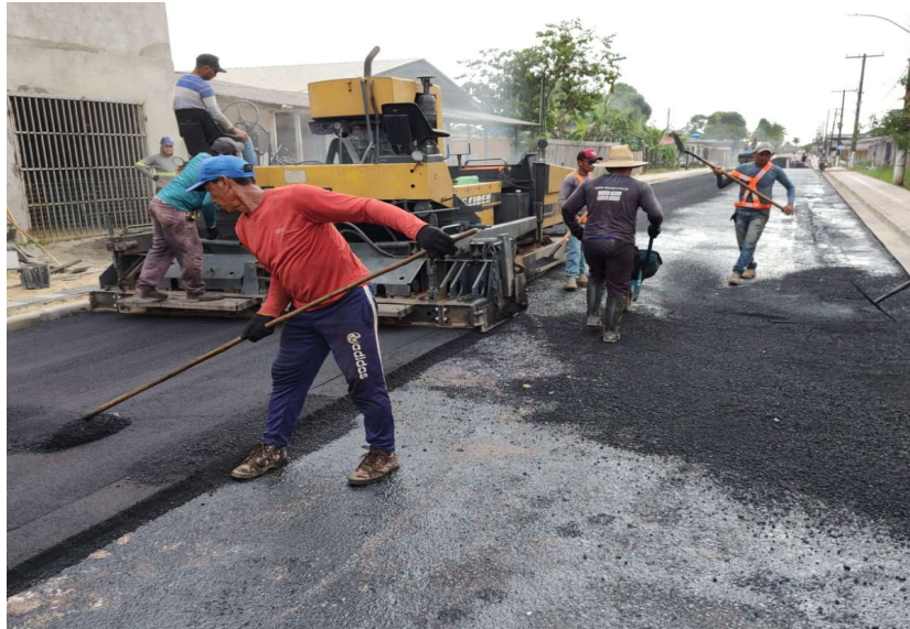
Figura 118 – Execução de Recapeamento Asfáltico.
