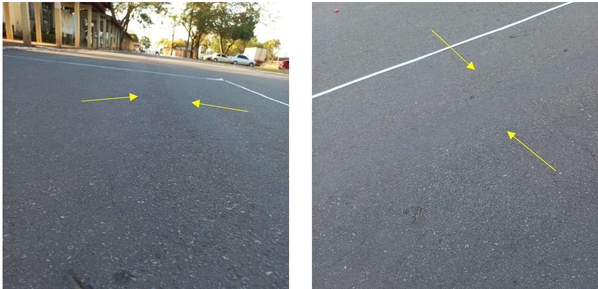
Figura 97 – Afundamento de Consolidação de Trilho de Roda - Área de avaliação 21.
