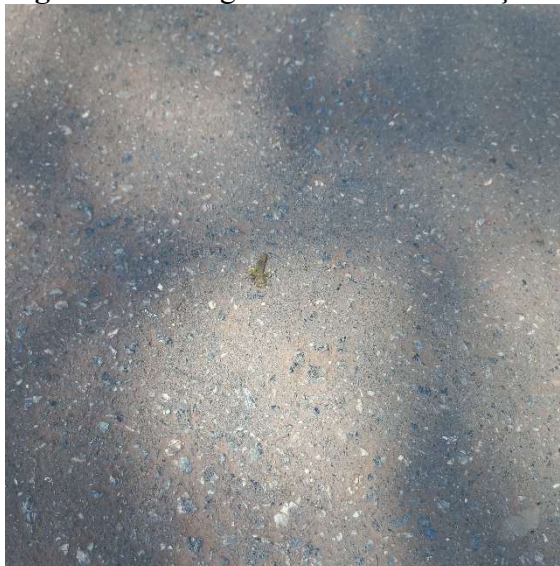
Figura 87 – Desgaste - Área de avaliação 18.
