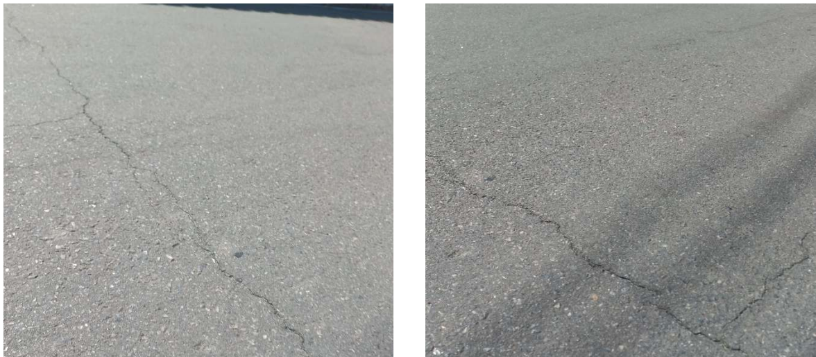
Figura 73 – Desgaste - Área de avaliação 14.
