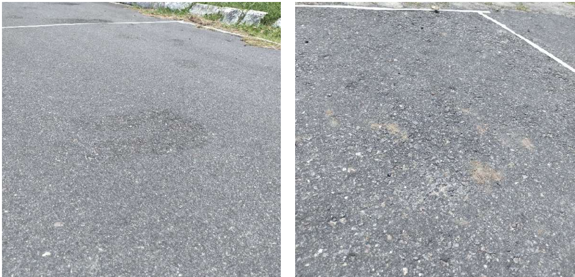
Figura 28 – Desgaste – Área de avaliação 1.
