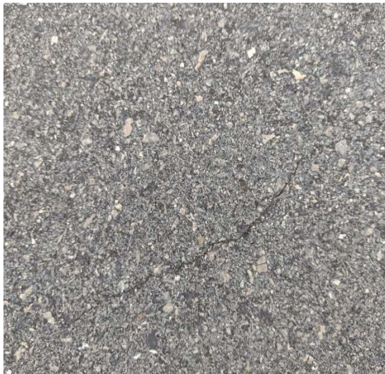
Figura 30 – Trinca Isolada Transversal Curta e Desgaste - Área de avaliação 2.
