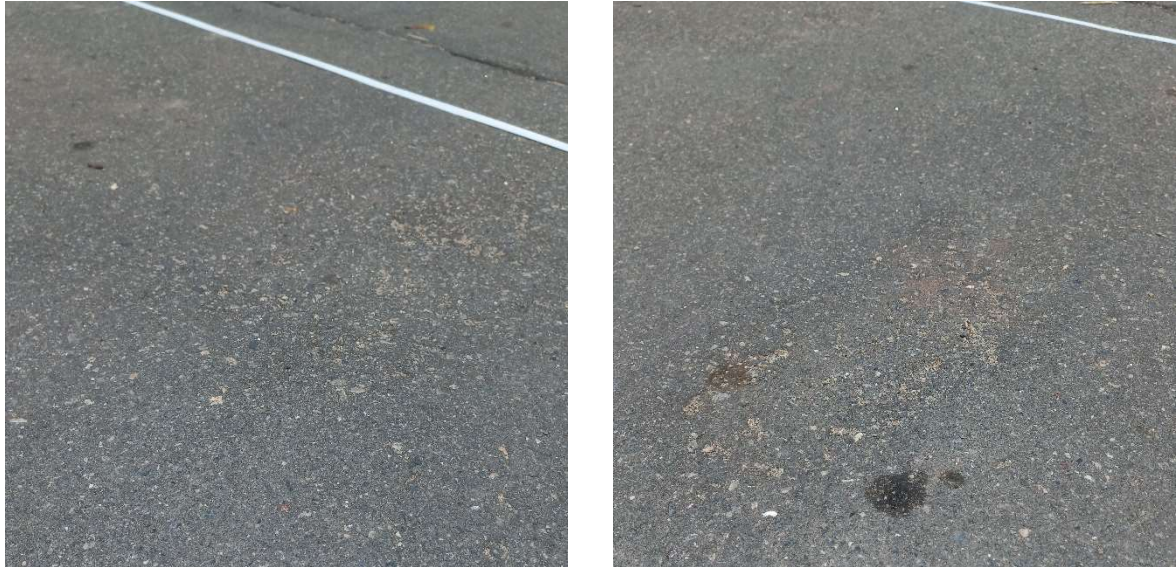
Figura 61 – Desgaste - Área de avaliação 11.
