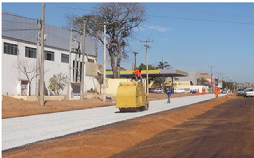
Figura 116 – Execução de Tratamento Superficial Duplo (TSD).
