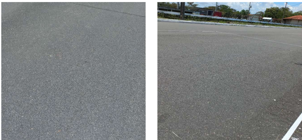
Figura 47 – Desgaste - Área de avaliação 7.
