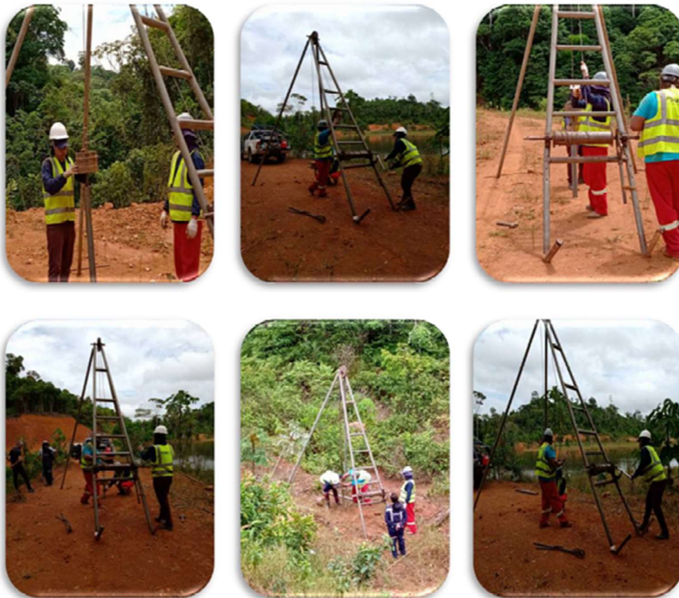
Figura 31 – Registros da realização do ensaio SPT em diversos pontos.
