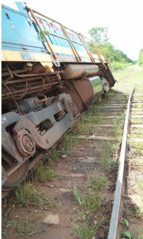
Figura 19 - Deterioração dos Trilhos
