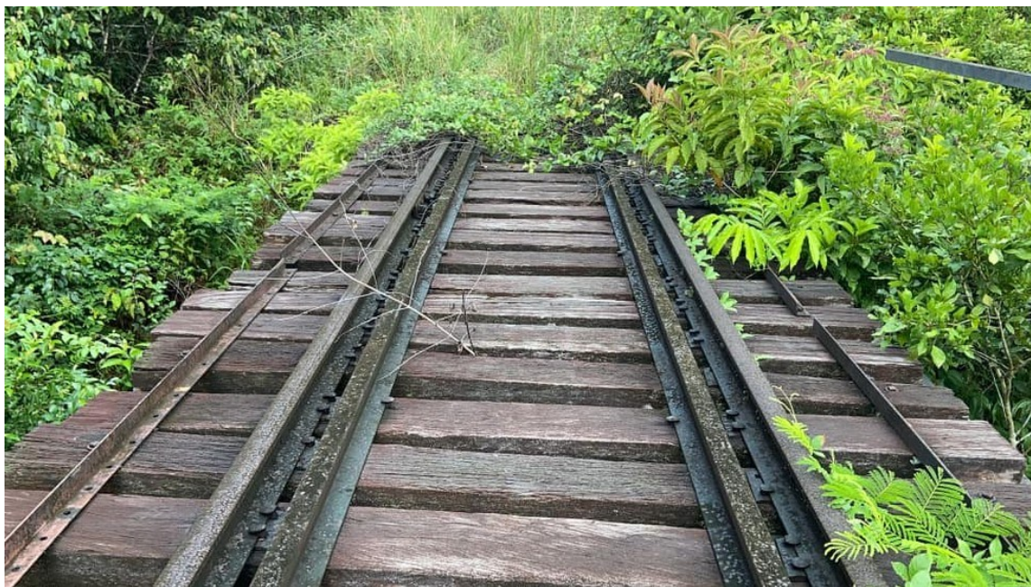
Figura 17 - Trecho da Rodovia Abandonada
