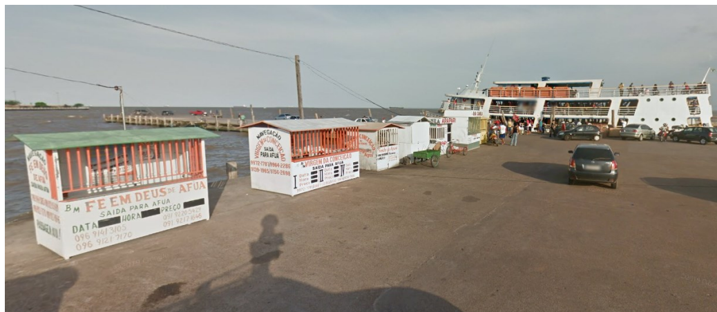
Figura 9 - Infraestrutura da Rampa do bairro Santa Inês
