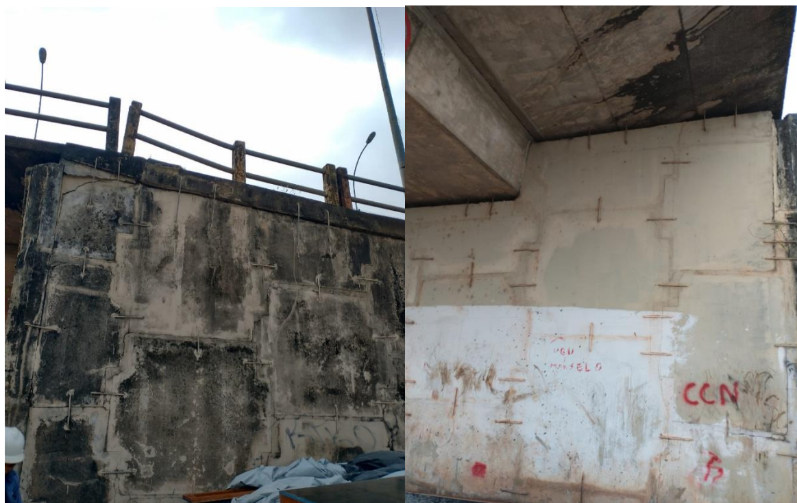
Figura 23 - Grampos aplicados na cabeceira e tabuleiro
