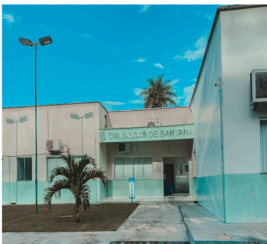
FIGURA 6. Prédio Administrativo da CDSA.
