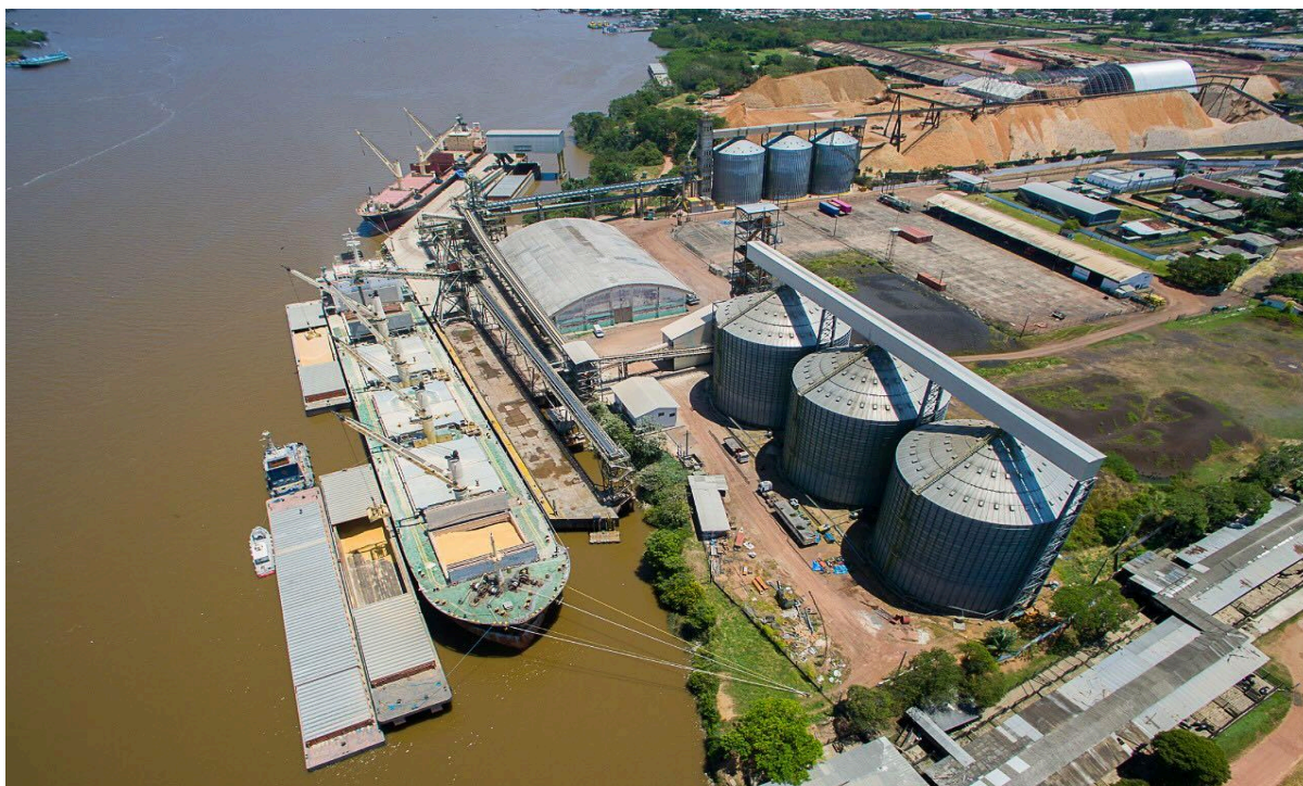
FIGURA 8. Infraestrutura do Porto de Santana.
