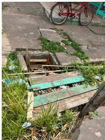
Fotografia 12 – dispositivo obstruído
