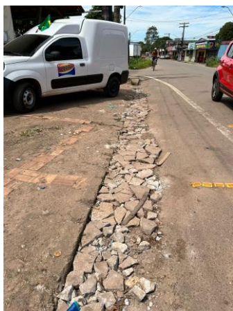
Fotografia 6 – sarjeta comprometida
