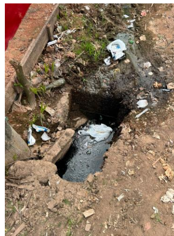
Fotografia 13 – obstrução e dejetos no dispositivo
