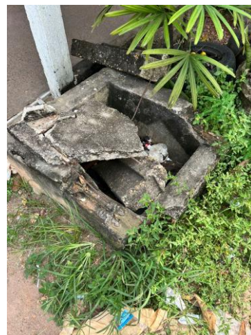
Fotografia 11 – tampa danificada
