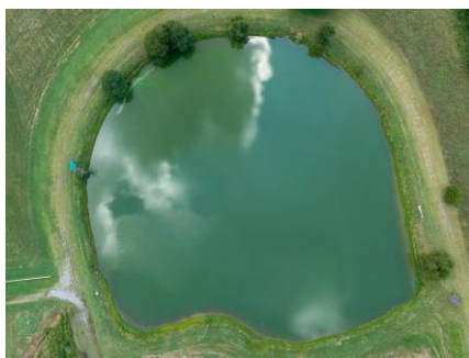
Figura 4 – Vista aérea de uma bacia de retenção
