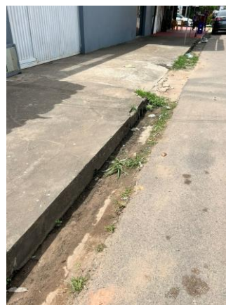
Fotografia 7 – sarjeta com vegetação
