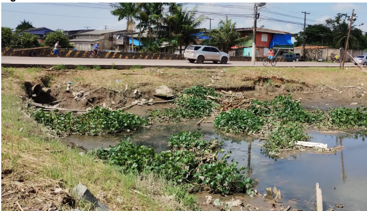
Figura 6: Ponto de escoamento no canal das Pedrinhas
