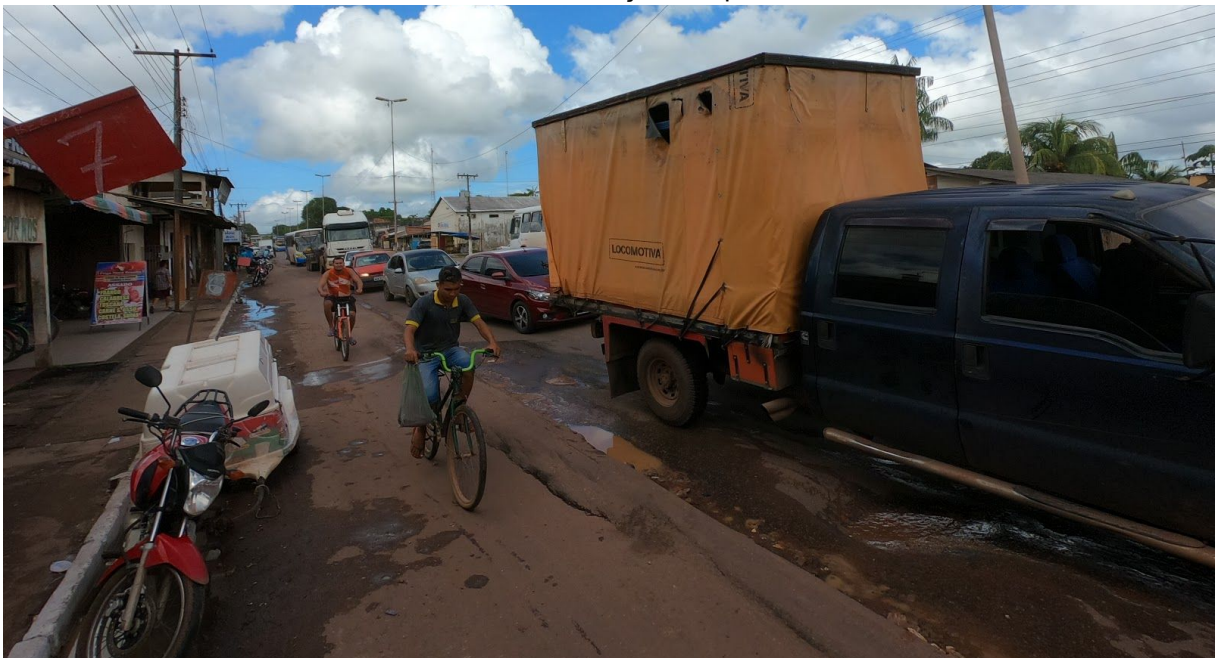
Figura 27 - Rodovia Juscelino Kubitschek, trecho Santana, formação de congestionamento em decorrência das condições do pavimento
