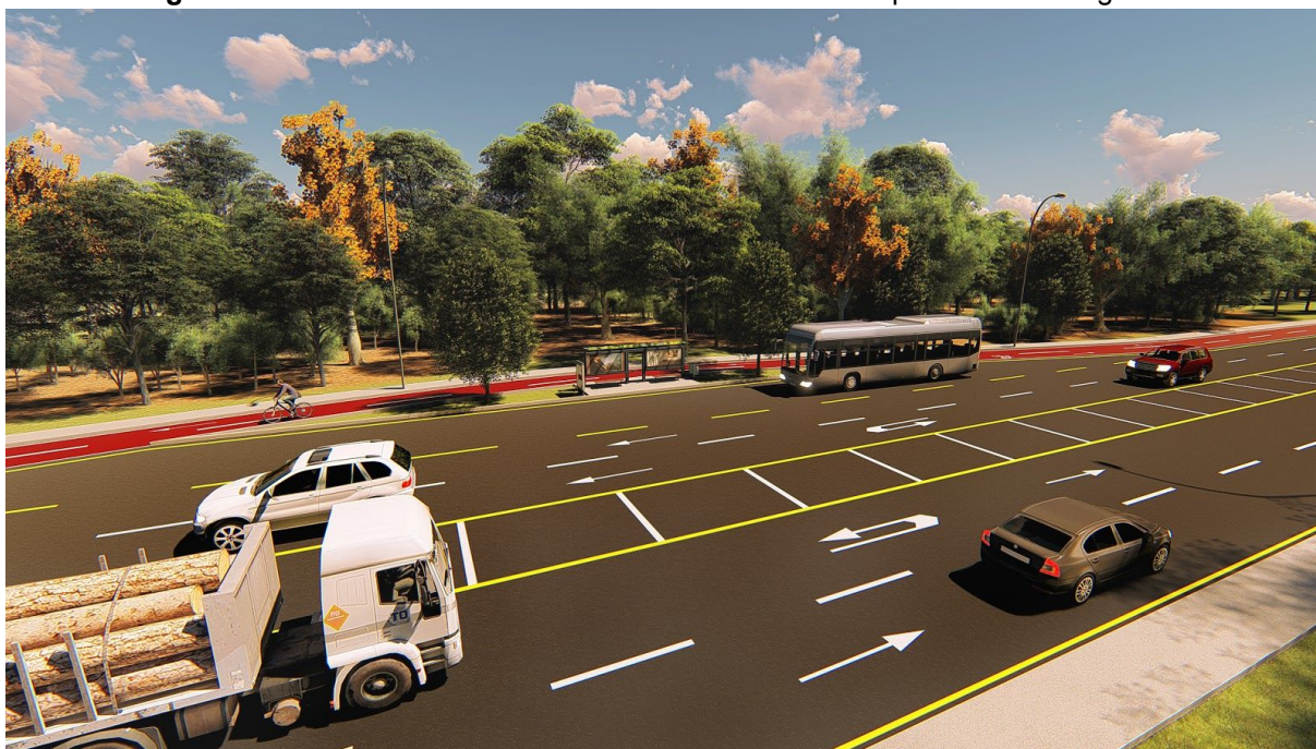
Figura 72 - Detalhe da faixa central destinada a retorno e parada de emergência
