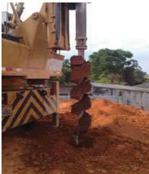
Figura 2.2 - Exemplo de Estaca Escavada.
