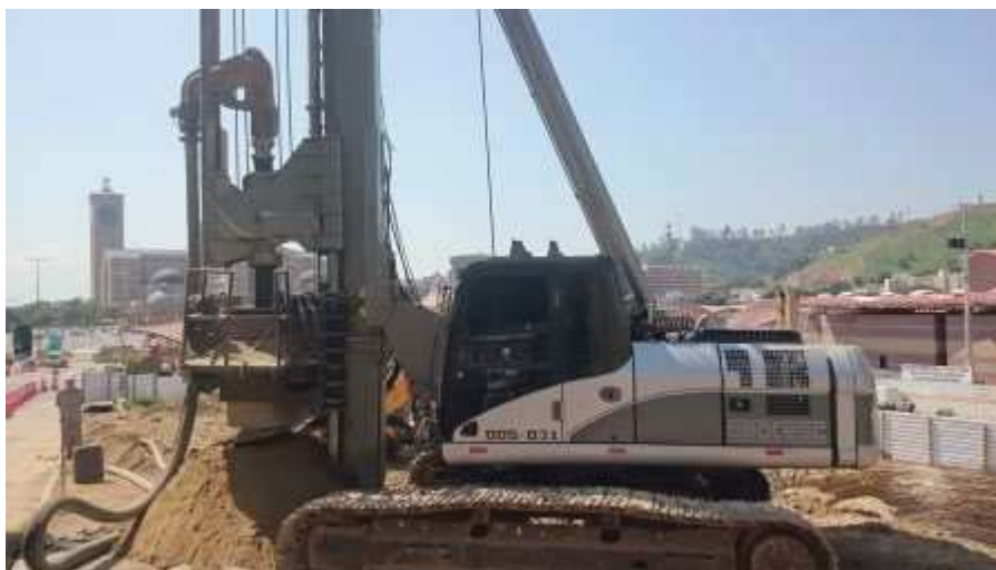
Figura 2.4 - Execução de Estaca Hélice Contínua Monitorada.
