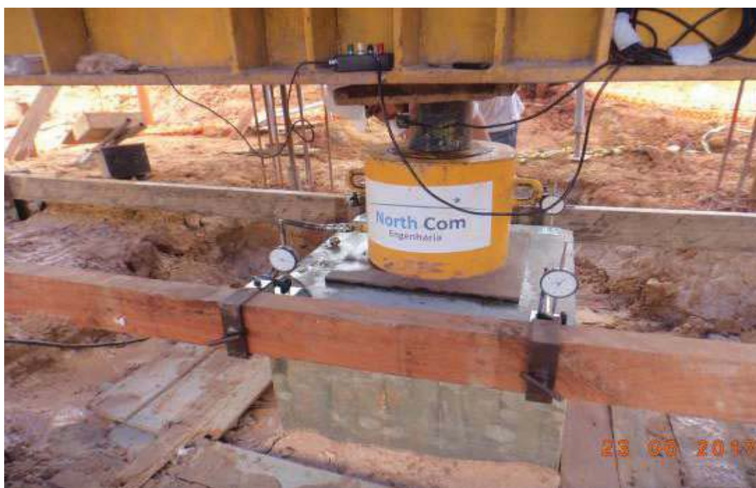
Figura 3.7 - Macaco hidráulico e célula de carga devidamente posicionados.
