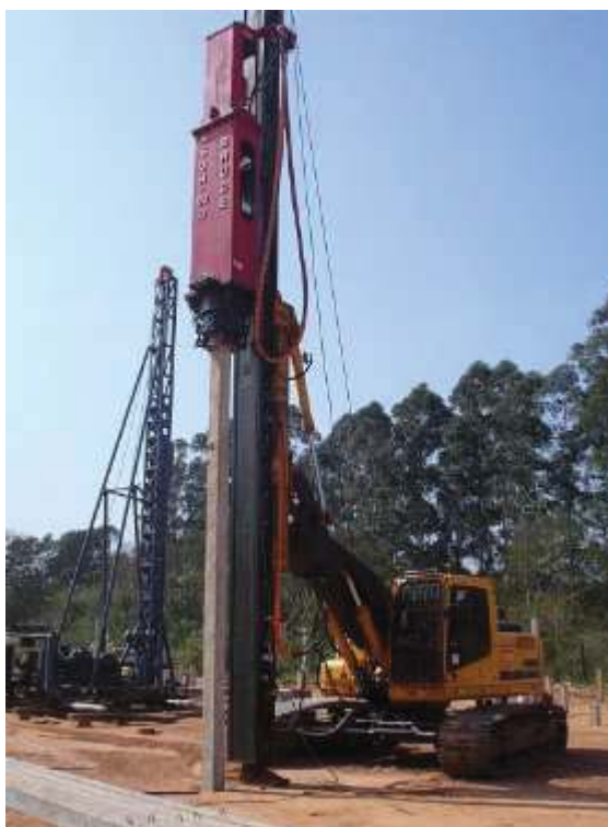
Figura 2.3 - Exemplo de Estaca Cravada.
