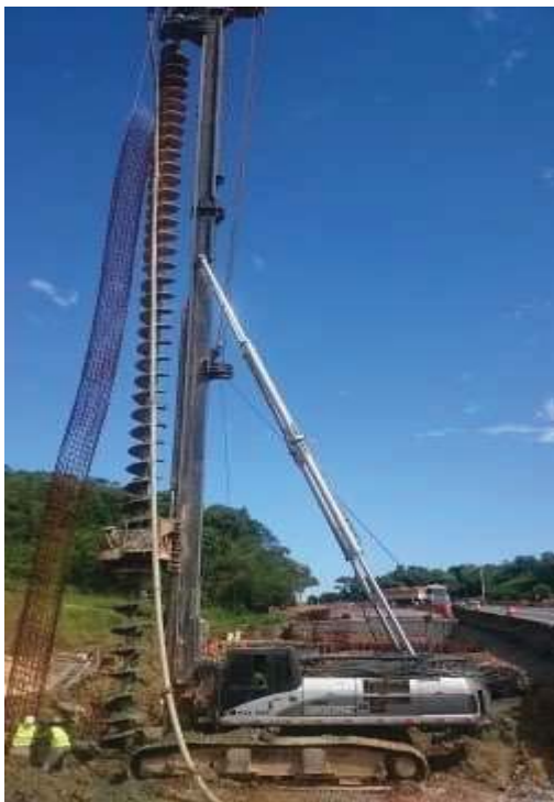
Figura 2.5 - Içamento de Armadura de Estaca Hélice Contínua.
