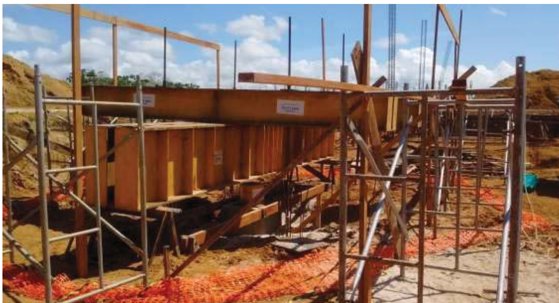
Figura 3.6 - Execução de Prova de Carga Estática no Hospital Universitário.
