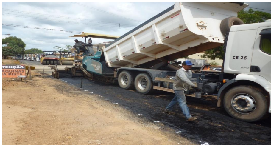
Figura 20 - Caminhão com caçamba metálica Fonte: Os autores (2018)
