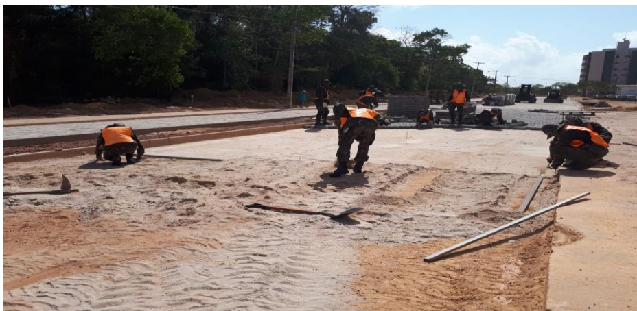
Figura 42 - Serviço de pavimentação de blocos Intertravados da Via 01 Fonte: Os autores (2018)
