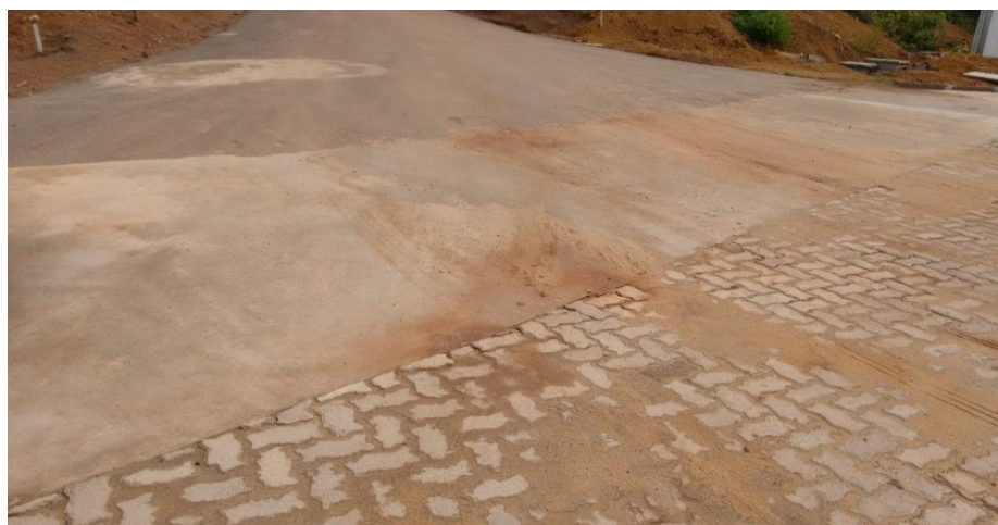
Figura 43 - Sarjetão em concreto armado entre a Via 01 e o Ram Toca da Onça Fonte: Os autores (2018)
