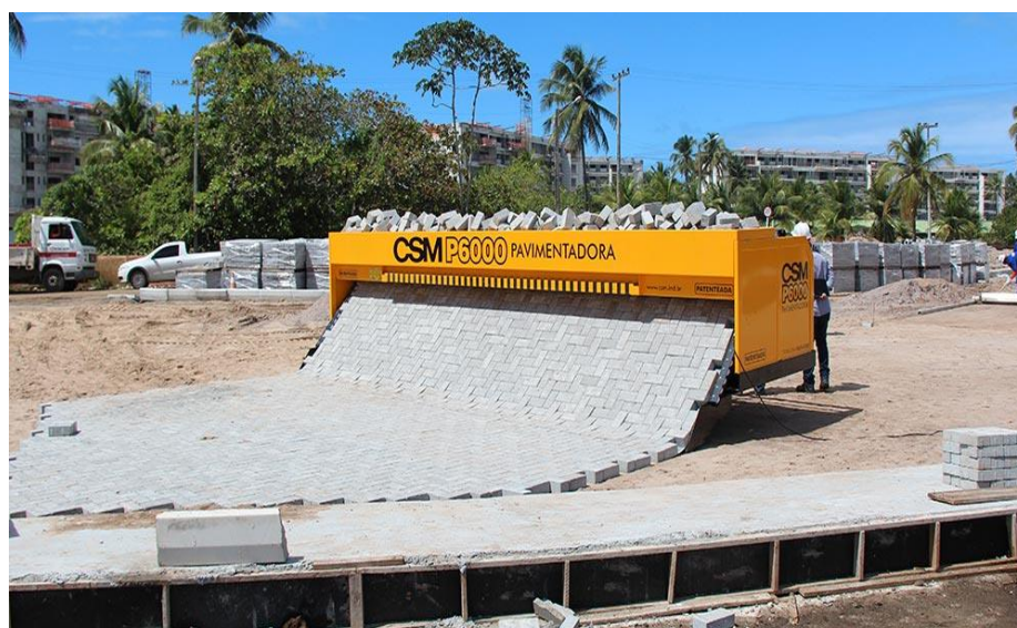
Figura 34 - Pavimentadora de paver
